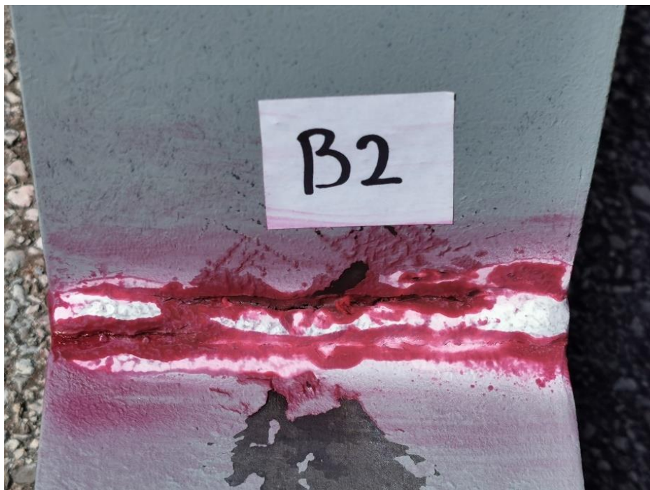
Slika 40: Velika pukotina na zavaru B2 (Izradio autor)
