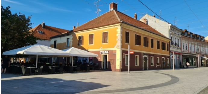
Slika 14; Stara građanska kuća, slikano 13. srpnja 2020., 18:40:13 (slika autora)
