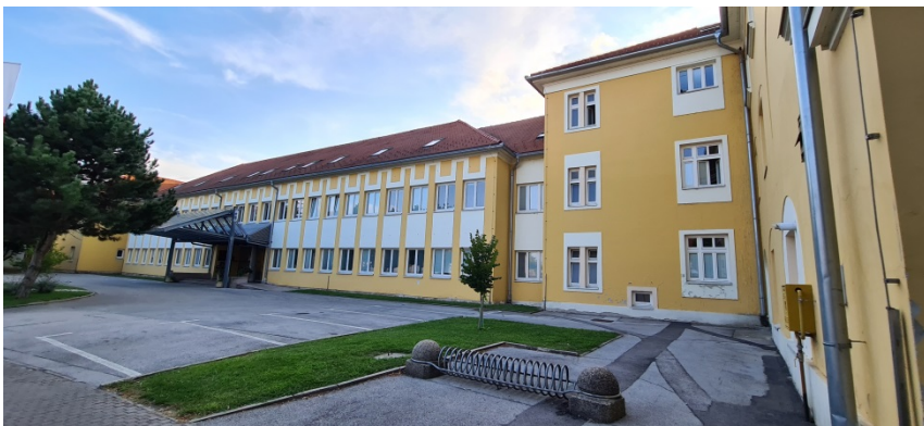
Slika 57; Građevina Međimurske županije, slikano 15. kolovoz 2020., 15:11:43 (slika autora)
