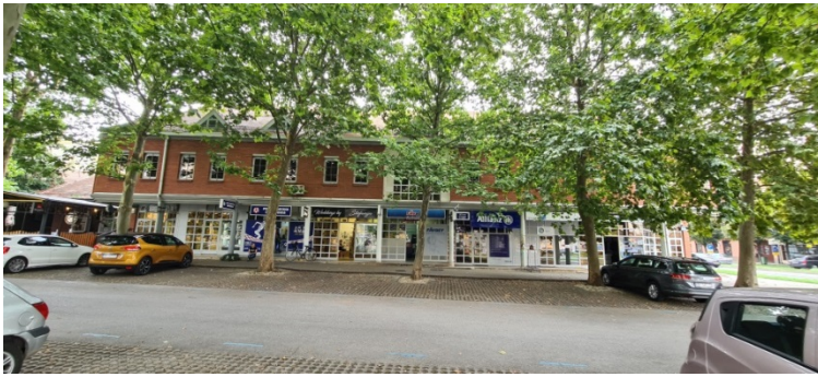
Slika 39; Zgrada s fasadom od cigli, slikano 11. kolovoz 2020., 16:07:19 (slika autora)
