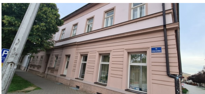
Slika 35; Bočni dio zgrade Nove vijećnice, slikano 11. kolovoz 2020., 16:02:36 (slika autora)
