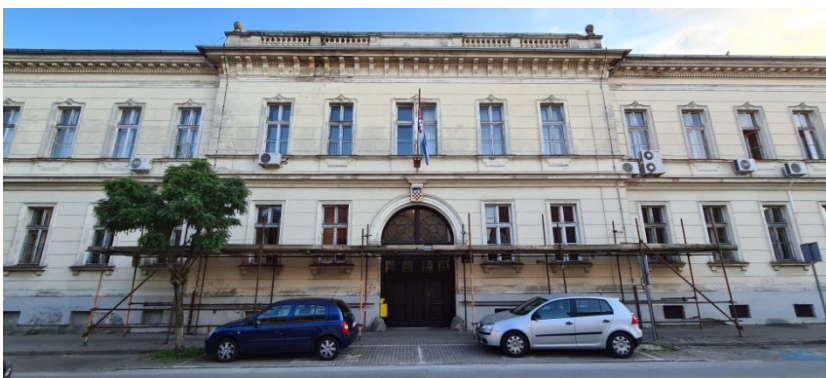
Slika 62; Građevina županijskog suda, slikano 15. kolovoz 2020., 15:17:59 (slika autora)
