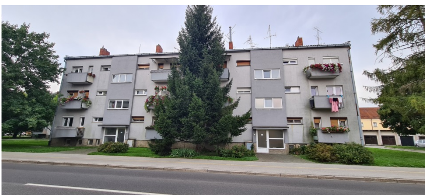
Slika 32; Zgrada iz 1940ih, slikano 11. kolovoz 2020., 15:54:50 (slika autora)
