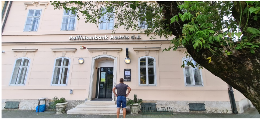
Slika 44, Raiffeisen banka, slikano 11. kolovoz 2020., 16:11:10 (slika autora)
