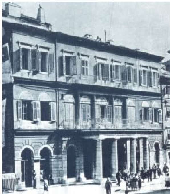
Slika 64: Zgrada Domoljubnog kazina, izgrađena 1845. godine
