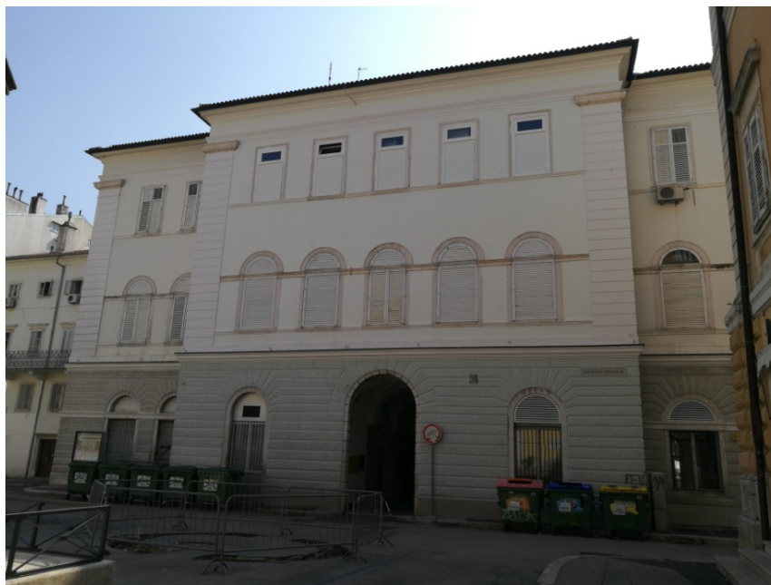
Slika 116: Zgrada Radio Rijeke, sjeverno pročelje.
