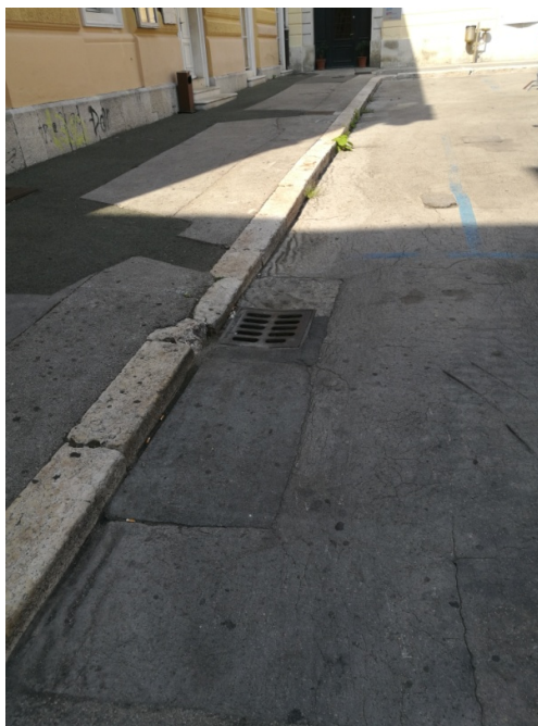
Slika 126: Šaht za odvodnju oborinske vode ispred restorana Municipium.
