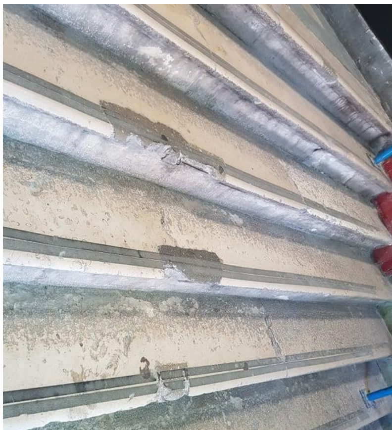
Slika 68. Oštećenje stubišta prizemlja (Foto: autor)
