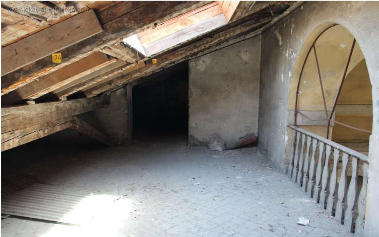
Slika 17. – Stanje krovišta prije početka obnove
