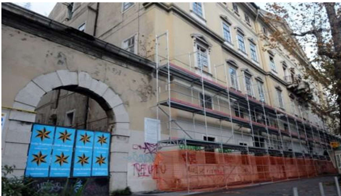
Slika 34. – Postavljanje skele na južno pročelje
