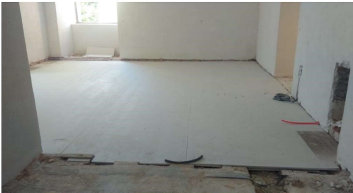
Slika 32. – Obnova podne konstrukcije 3. kata
