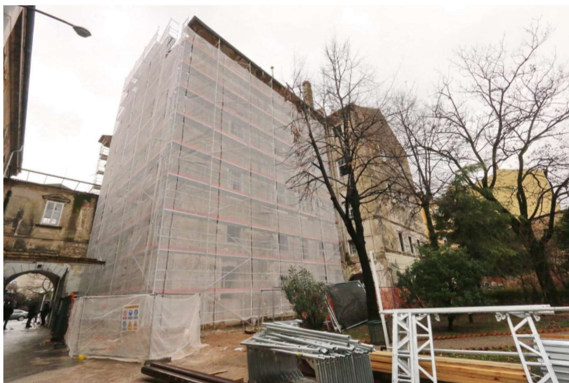
Slika 35. – Postavljanje skele na istočno i sjeverno pročelje
