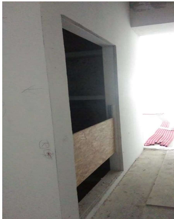
Slika 27. – Otvor za dizalo na 1. katu
