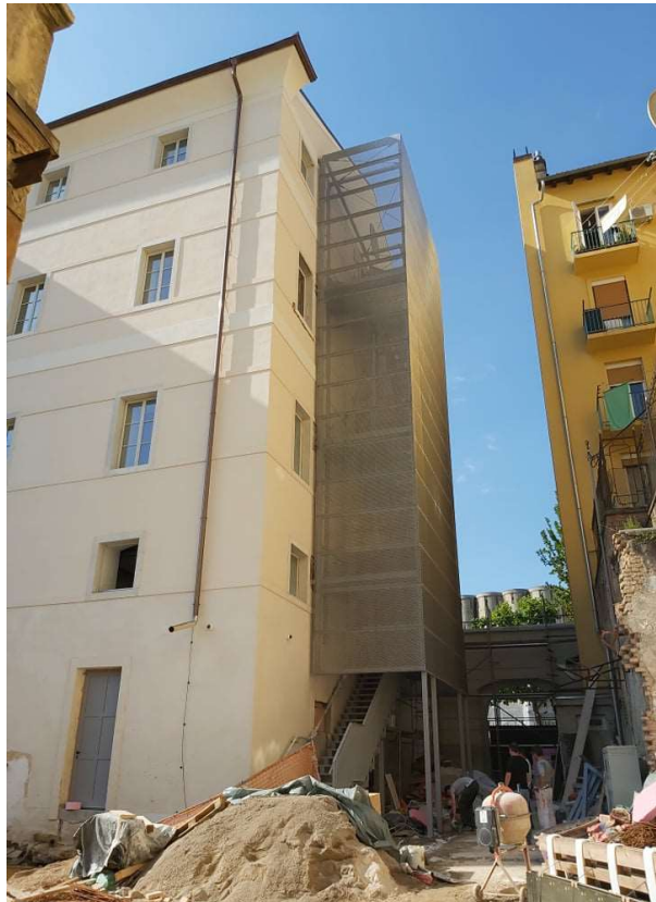
Slika 53. – Vanjsko (evakuacijsko) stubište na zapadnom pročelju
