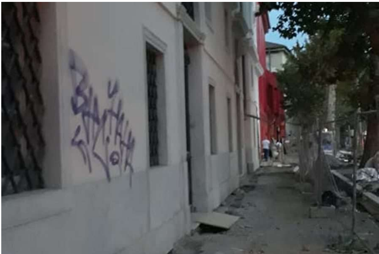
Slika 25. – Vandalizirano južno pročelje tijekom obnove
