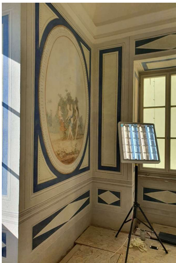
Slika 55. – Radovi na restauraciji zidnih oslika na 2. katu
