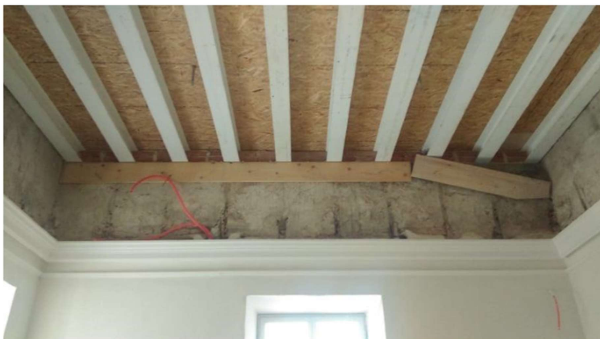
Slika 33. – Detalj stropnih greda 2. kata
