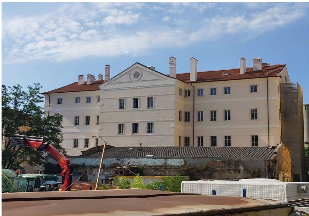
Slika 61. – Sjeverno pročelje nakon obnove
