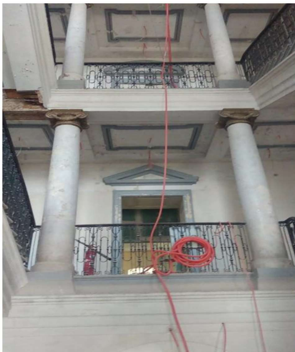
Slika 26. – Obnova unutarnjeg stubišta
