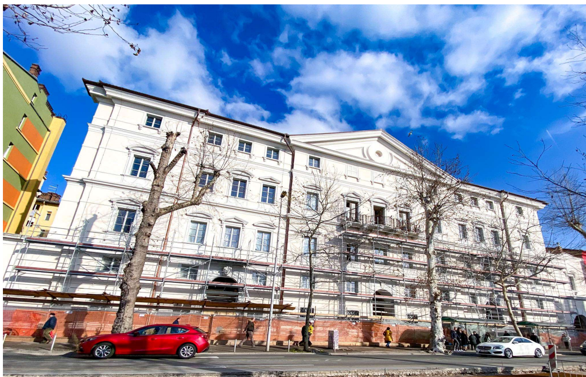
Slika 62. – Južno pročelje nakon obnove
