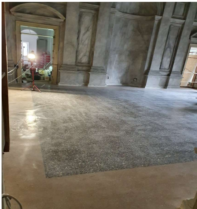
Slika 57. – Poliranje terazzo poda u velikoj dvorani na 2. katu
