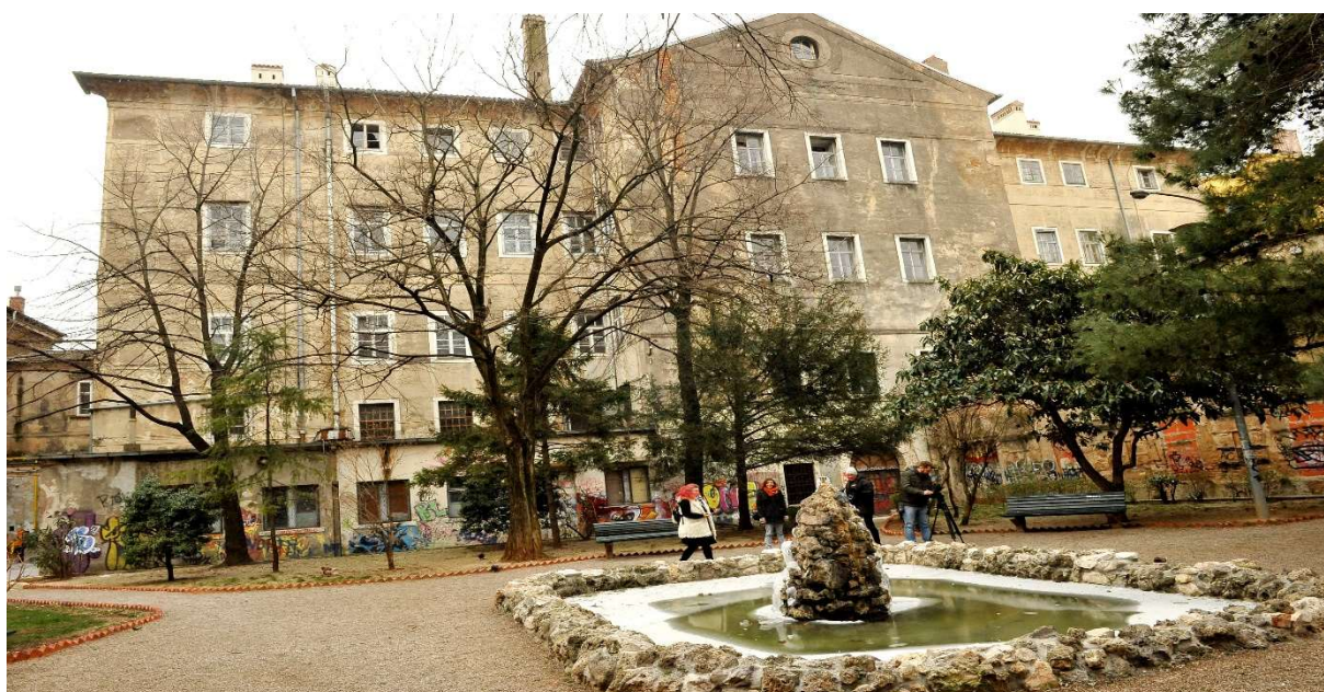
Slika 13. – Sjeverno pročelje prije obnove
