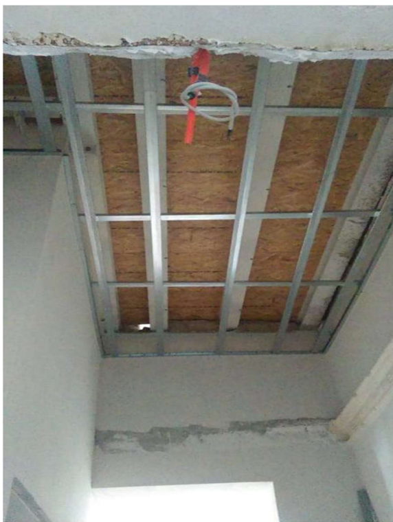
Slika 30. – Novi spušteni strop na 1. katu
