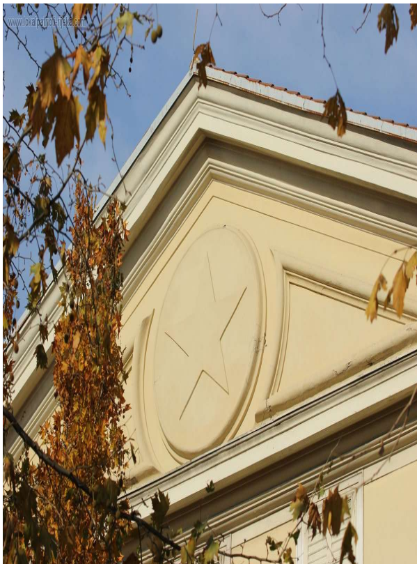
Slika 63. – Zabat prije obnove
