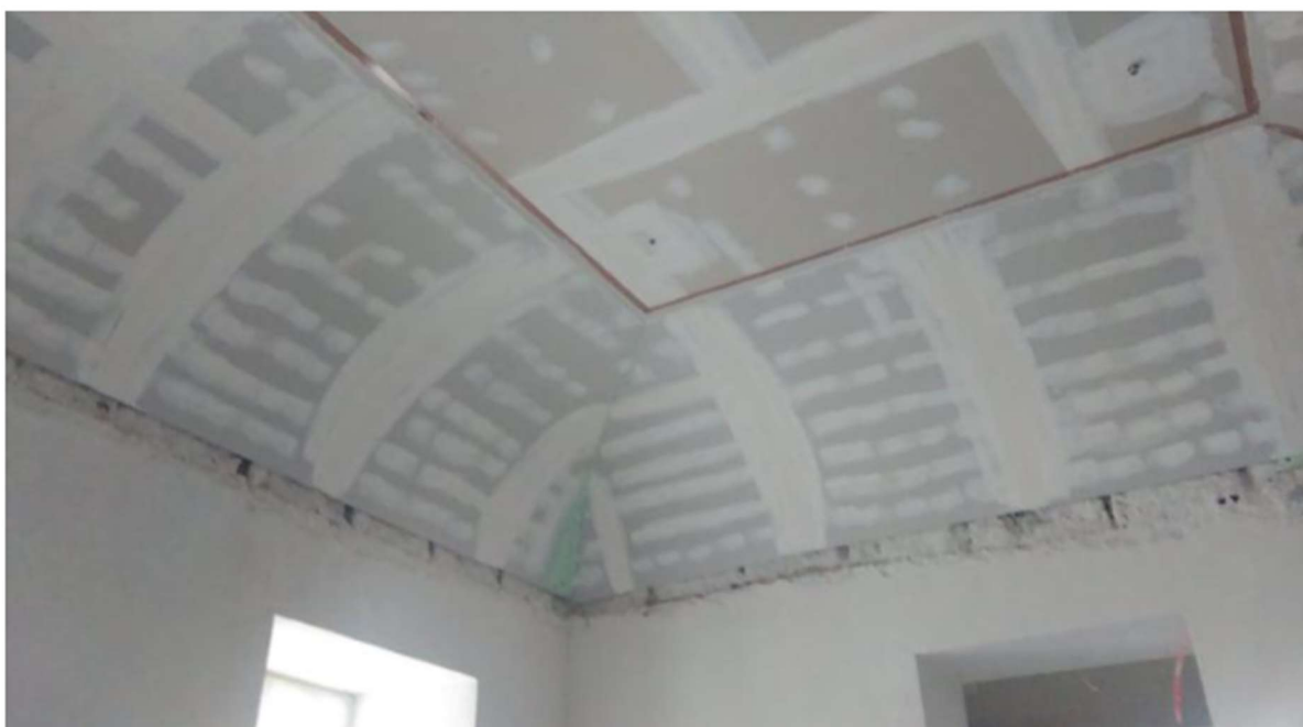
Slika 31. – Detalj obnove stropa na 1. katu
