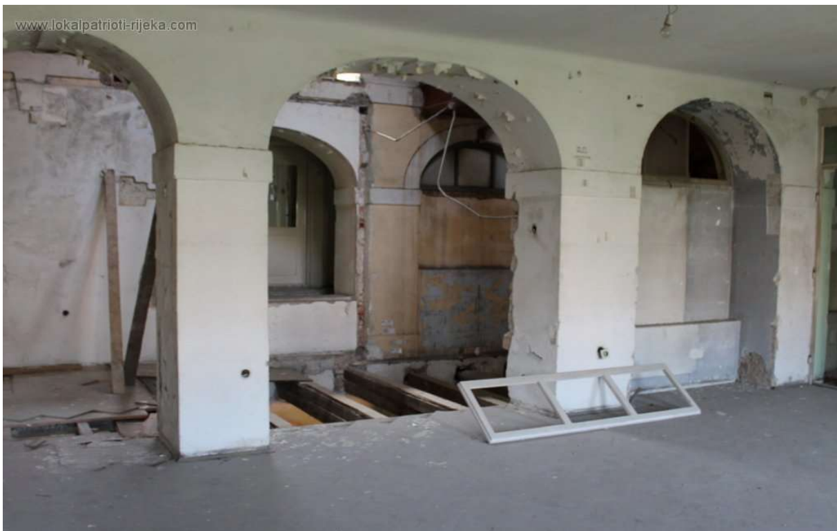
Slika 16. – Dio međukatne konstrukcije između 2. i 3. kata koji je projektom rekonstrukcije uklonjen
