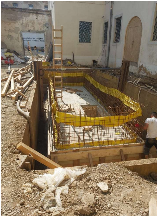
Slika 52. – Sprinkler bazen u izgradnji ispred sjevernog pročelja objekta
