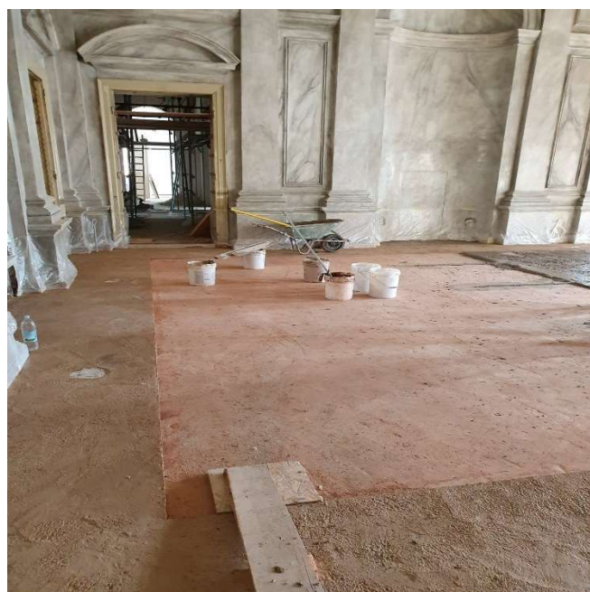
Slika 56. – Izrada terazzo poda u velikoj dvorani na 2. katu
