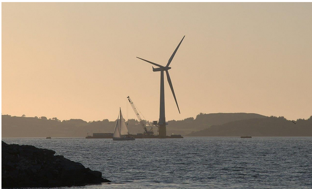
Slika 37. Prvi plutajući vjetroagregat, koji je sklopljen Stavangeru (Norveškoj), prije nego je postavljen u Sjevernom moru
