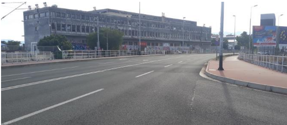
Slika 37: Pogled na most s prednje strane
