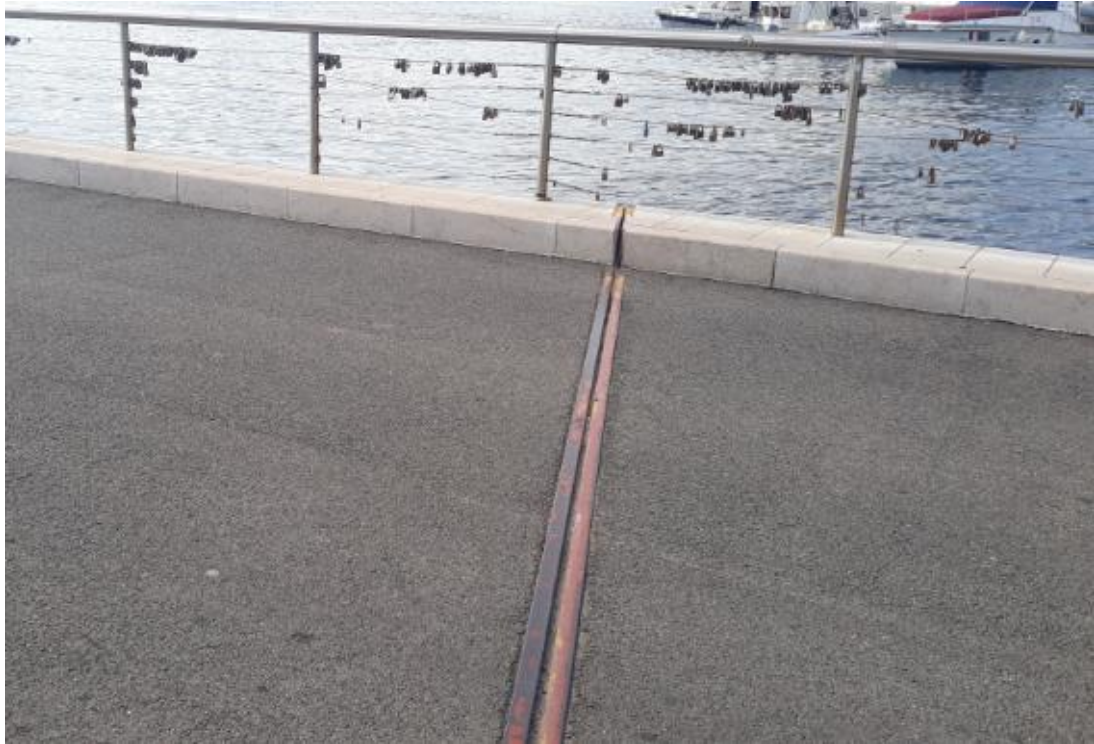
Slika 33: Prijelazna naprava na mostu
