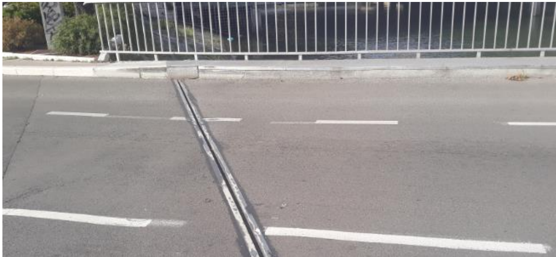
Slika 36: Prijelazna naprava na mostu
