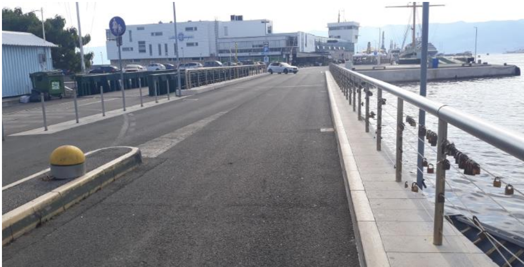
Slika 29: Pogled na most
