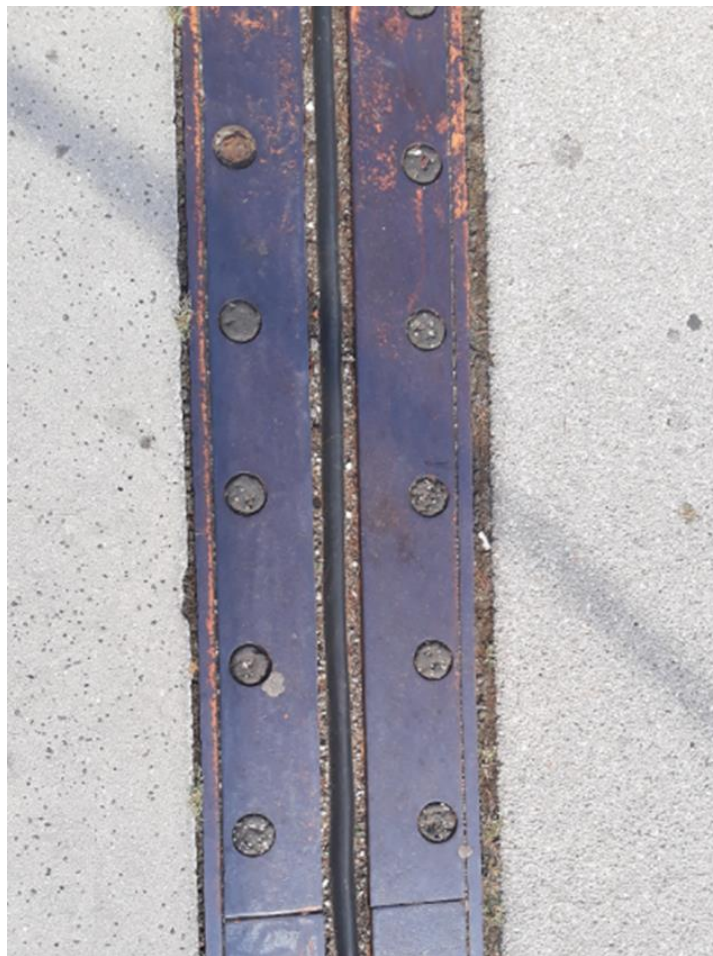
Slika 51: Prijelazna naprava na mostu
