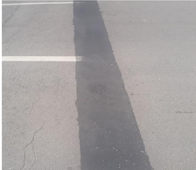
Slika 2: Bitumenska reška
