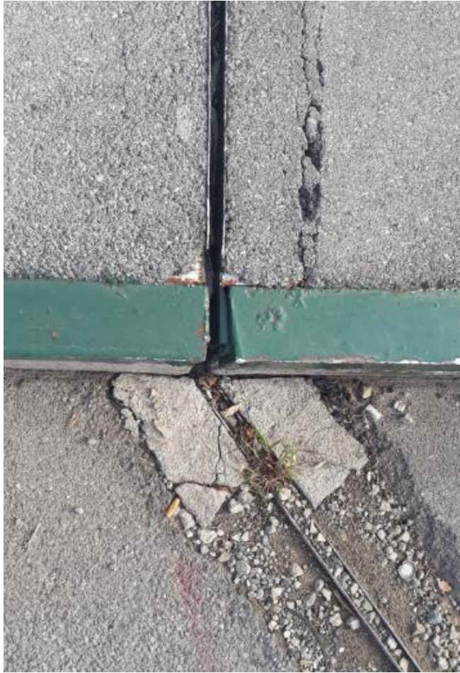
Slika 44: Prijelazna naprava na mostu
