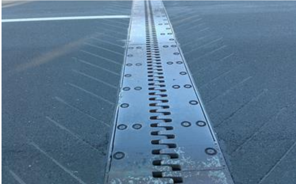
Slika 20: Letvasta naprava s valovito nazubljenom limenom oblogom[16]
