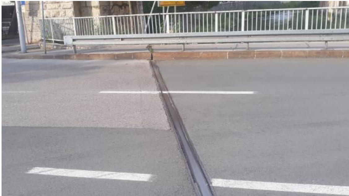
Slika 26: Prijelazna naprava na početku mosta
