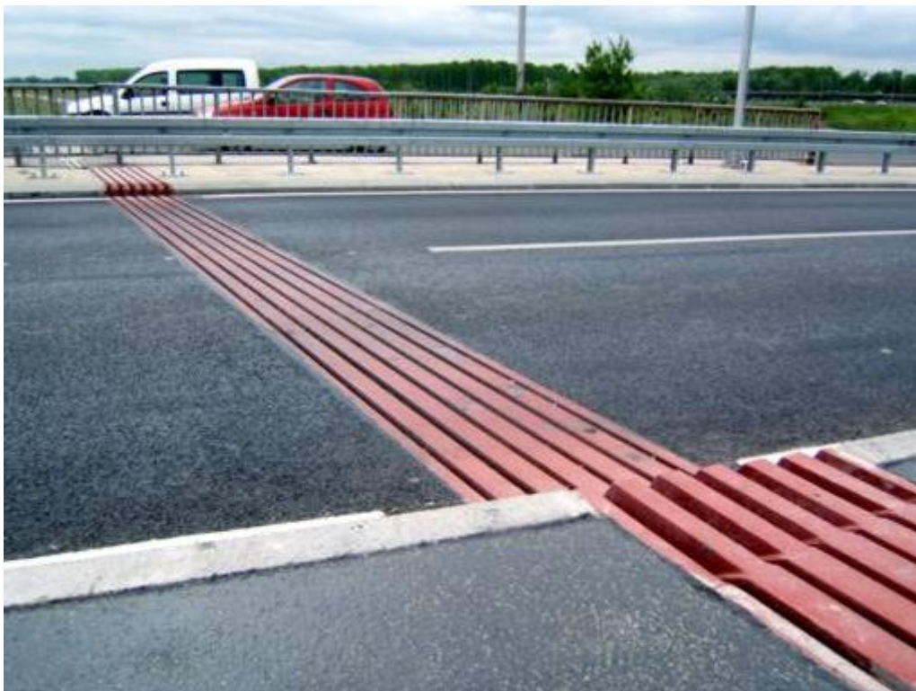
Slika 11: Naprava s elastomernim brtvenim uloščima[9]
