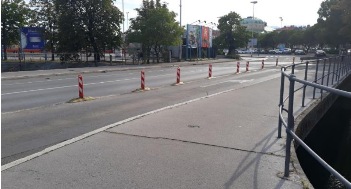
Slika 48: Pogled na most
