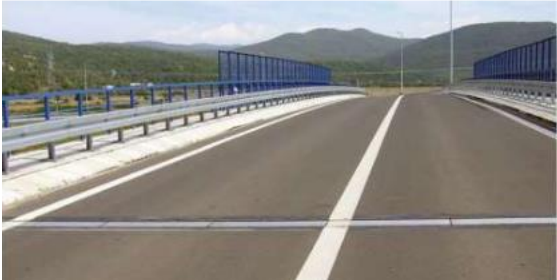
Slika 9: Elastomerna prijelazna naprava [6]
