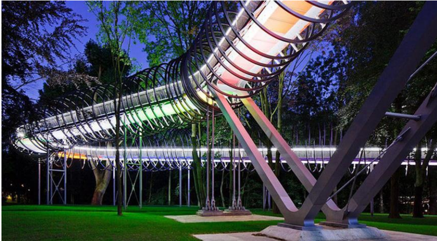
Slika 21: Most Slinki, Oberhausen [16]
