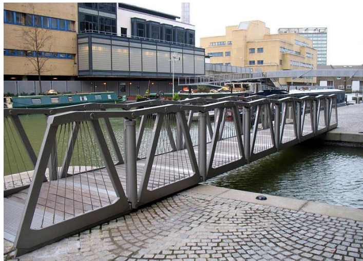
Slika 31: Prikaz mosta u rasklopljenoj fazi [25]
