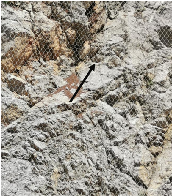
Slika 22. Detalj mjesta mogućeg trošenja (Fotografija: Filip Marfan).
