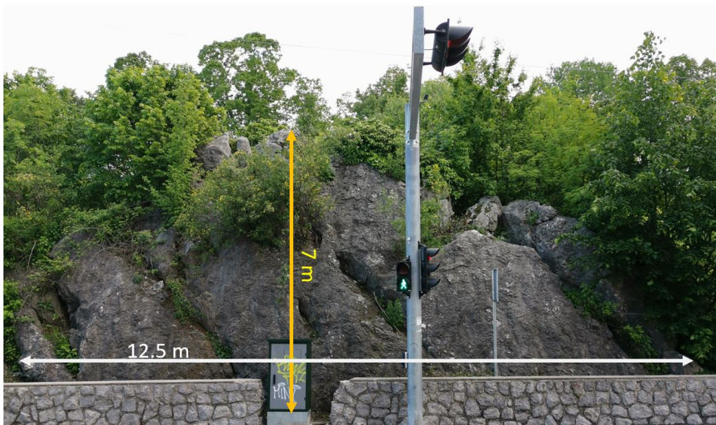
Slika 16. Geometrijske značajke stijenskog pokosa na lokaciji T2 (Fotografija: Filip Marfan).
