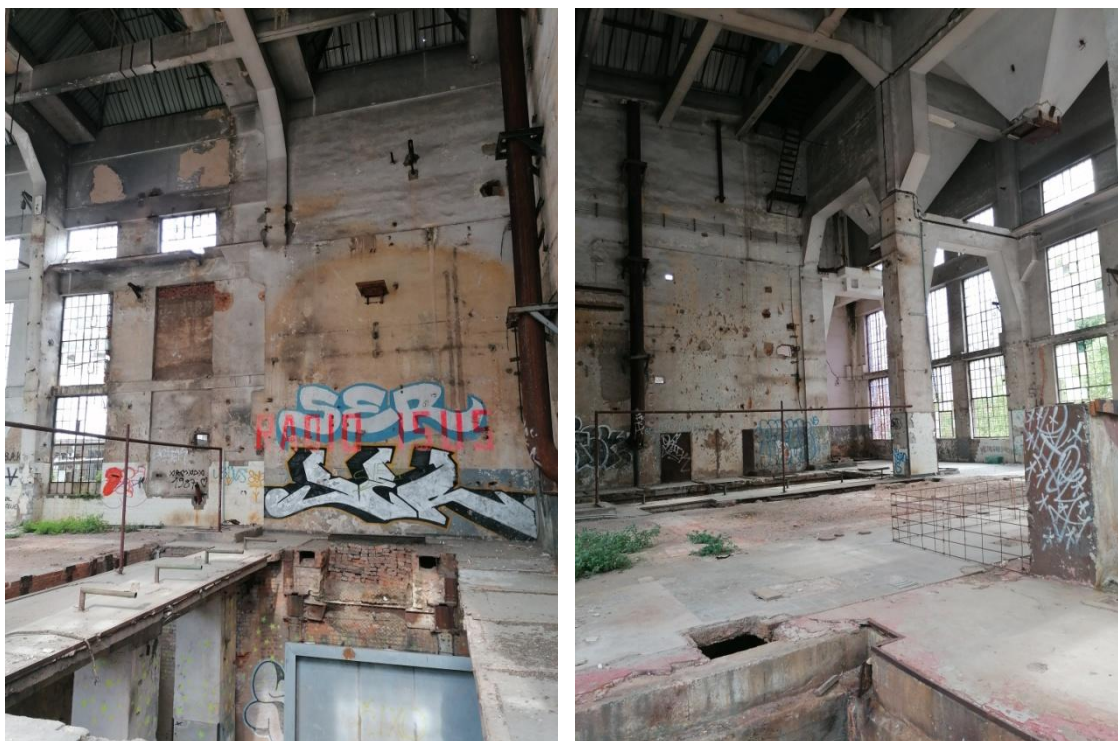
Slika 72. „Dvorana kotlova“ na prvom katu zgrade
