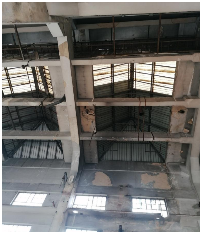
Slika 74. Rešetkasta armiranobetonska konstrukcija stropa iznad "dvorane kotlova"
