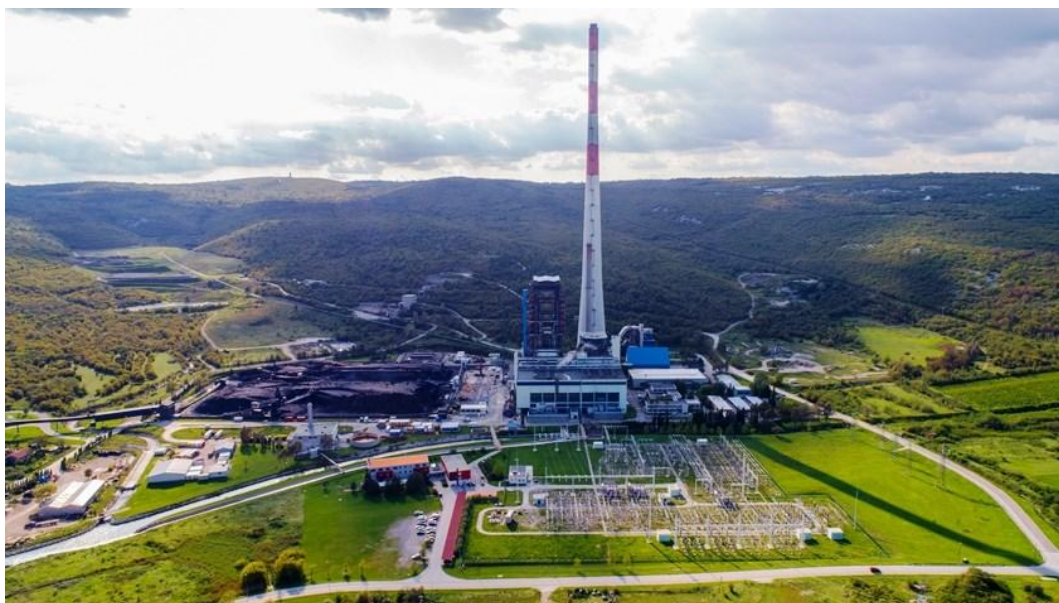
Slika 6. Postrojenje termoelektrane na ugljen, Plomin
