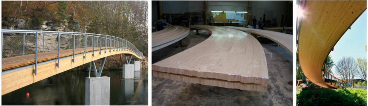
Slika 100: Prikaz zakrivljenog LLD nosača mosta[14]
