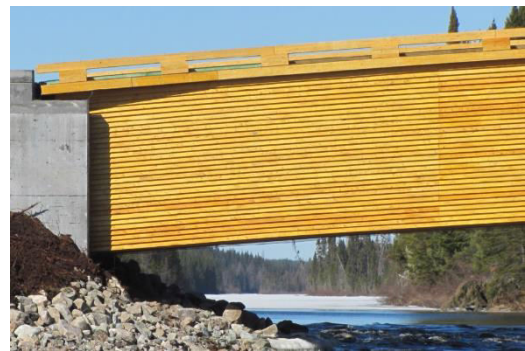
Slika 21: Zaštita glavnog nosača oblogama (desna slika) [5]
