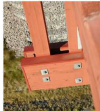
Slika 22: (lijeva slika) razvoj pukotina zbog nezaštićenog čeonog presjeka, (desna slika) zaštita kratkim čeličnim elementima kod izloženog dijela drva kod spoja[5]
