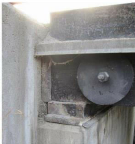
Slika 18: Uvučenost ležaja ispod nosača (desna slika) – zaštita od zadržavanja vode[5]
