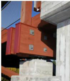
Slika 24: Primjer kvalitetnog detalja spoja i oslanjanja (lijeva slika), primjer premaza i spoja ograde (desna slika) [5]
