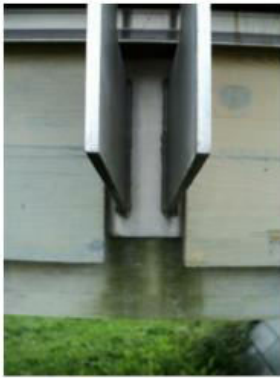
Slika 23: Produženi čelični dio radi odvajanja vode od konstrukcije (desna slika), čelični element uz drveni dio pospješuje smjer vode u drveni dio konstrukcije – loš detalj (lijeva slika) [5]
