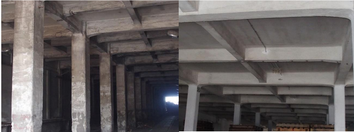
Slika 5: Prikaz stupova u zgradi
