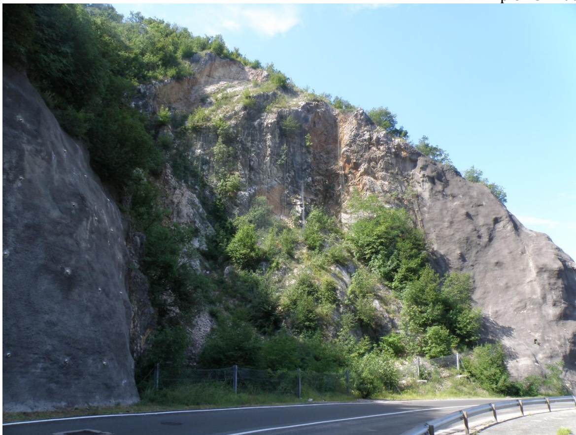
Slika 18: Dio analizirane stijenske kosine
