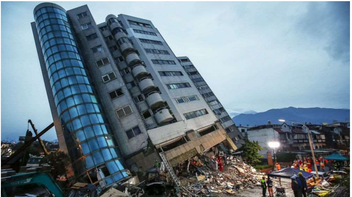
Slika 1: Zgrada nakon potresa
