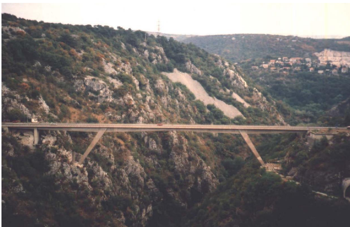
Slika 8. Pogled na most Rječina iz zraka [8]
