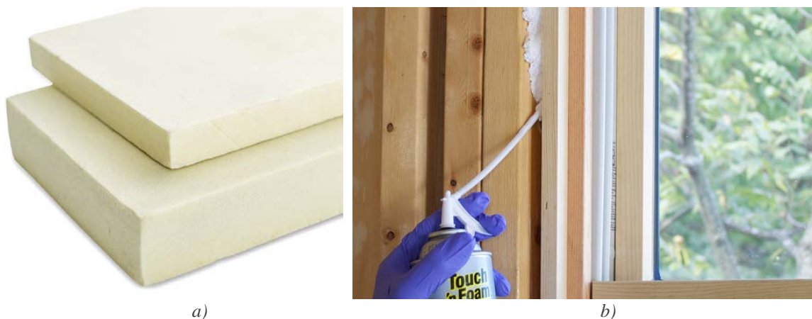
Slika 2.16 a) Ploča poliuretanske pjene, b) instalacija poliuretanskog spreja
