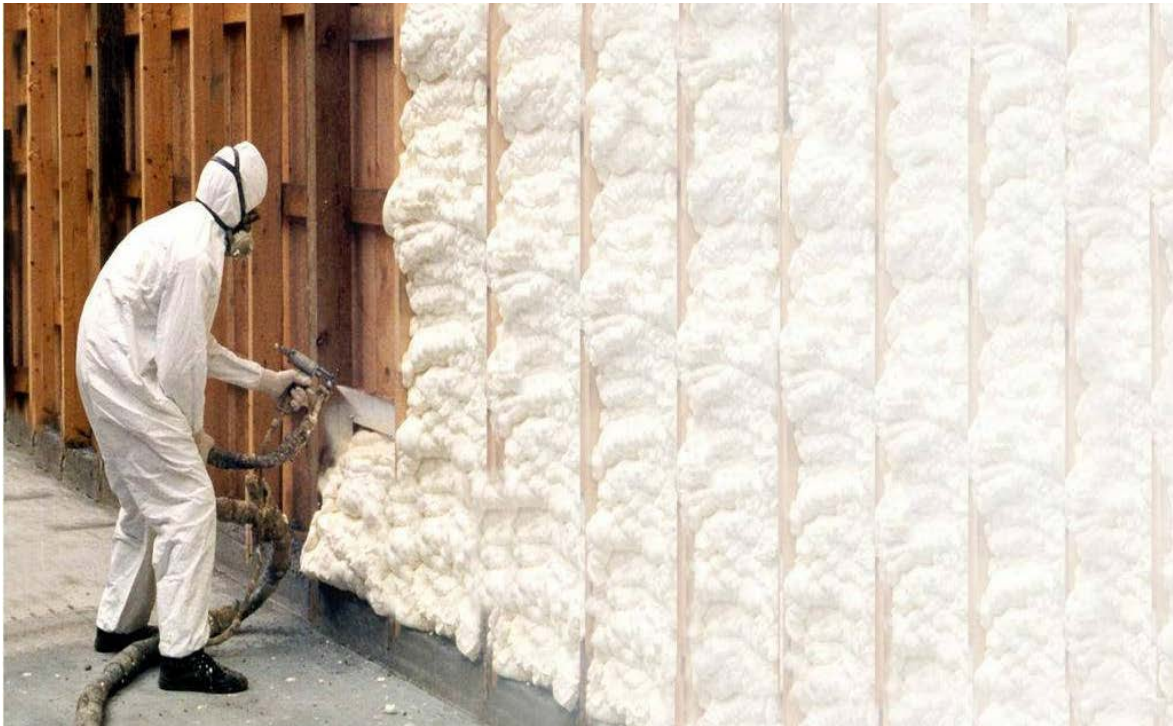
Slika 2.15 Instalacija poliuretanske (PUR) pjene
