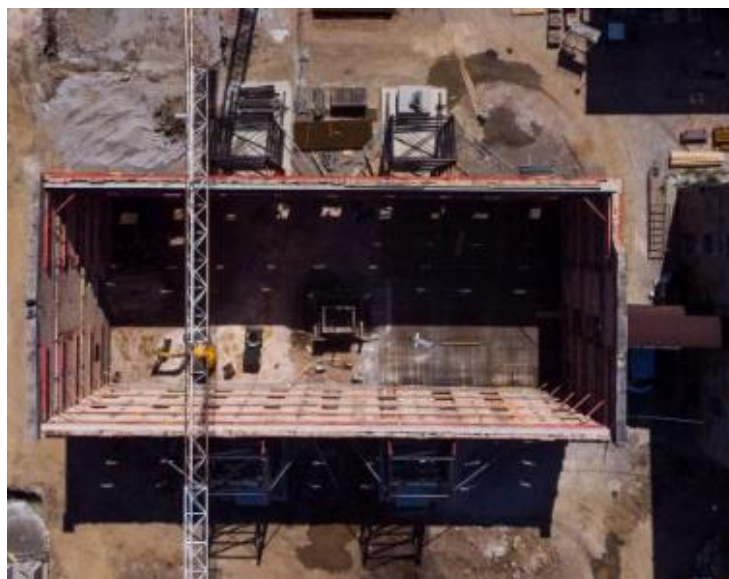
Slika 33: Četiri zadržana vanjska fasadna zida [13]
