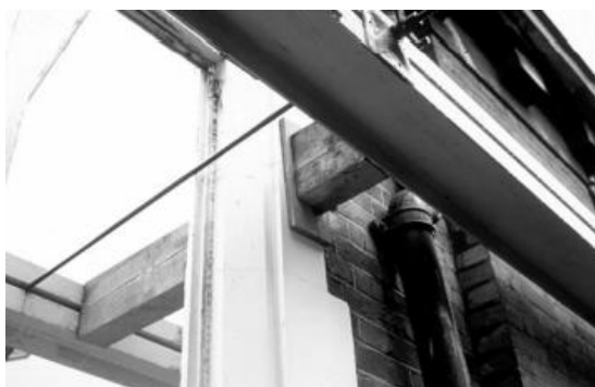
Slika 15: Spoj fasade i skele pomoću drva i spojnih sredstava [2]
