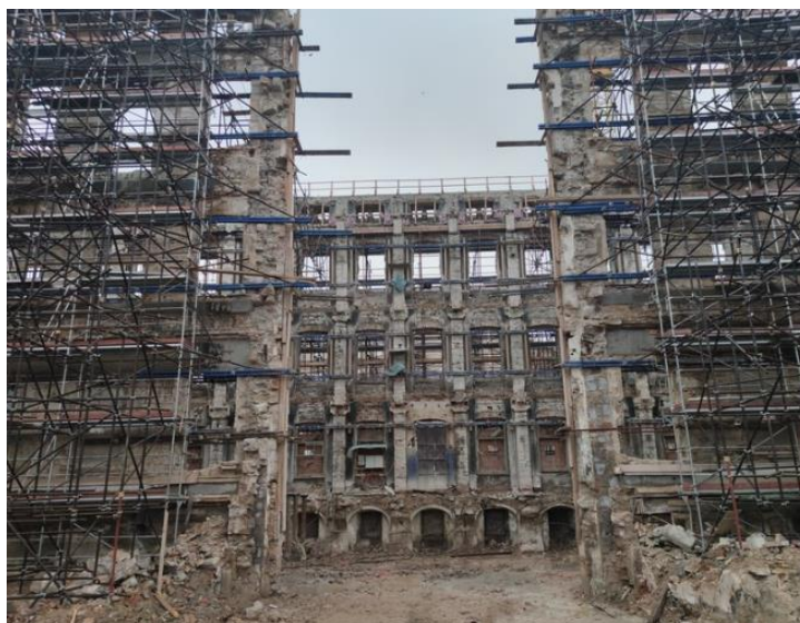
Slika 29: Vanjska skela za pridržavanje fasade [12]
