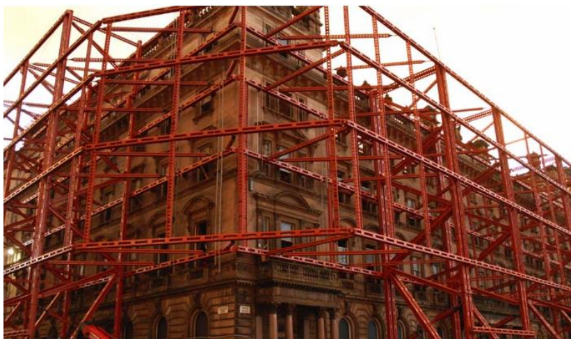
Slika 24: Privremena konstrukcija za pridržavanje fasade [9]
