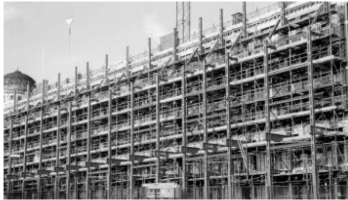
Slika 19: Vanjski konstrukcija za pridržavanje fasade [2]
