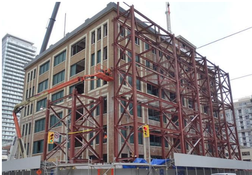
Slika 4: Vanjska privremena konstrukcija za pridržavanje fasade [5]
