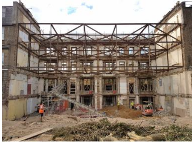
Slika 13: Rešetkasti razuporni nosač [1]
