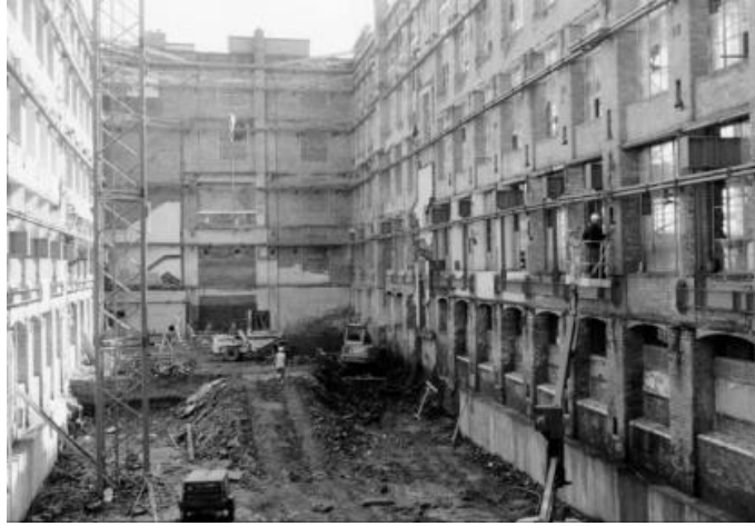
Slika 18: Unutarnji dio konstrukcije za pridržavanje fasade [2]
