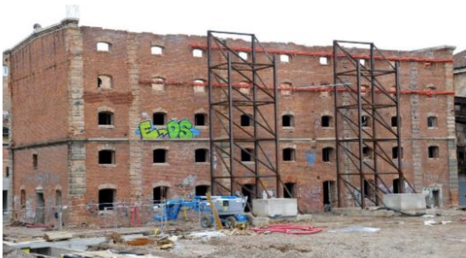
Slika 36: Teška skela za zadržavanje fasade [16]
