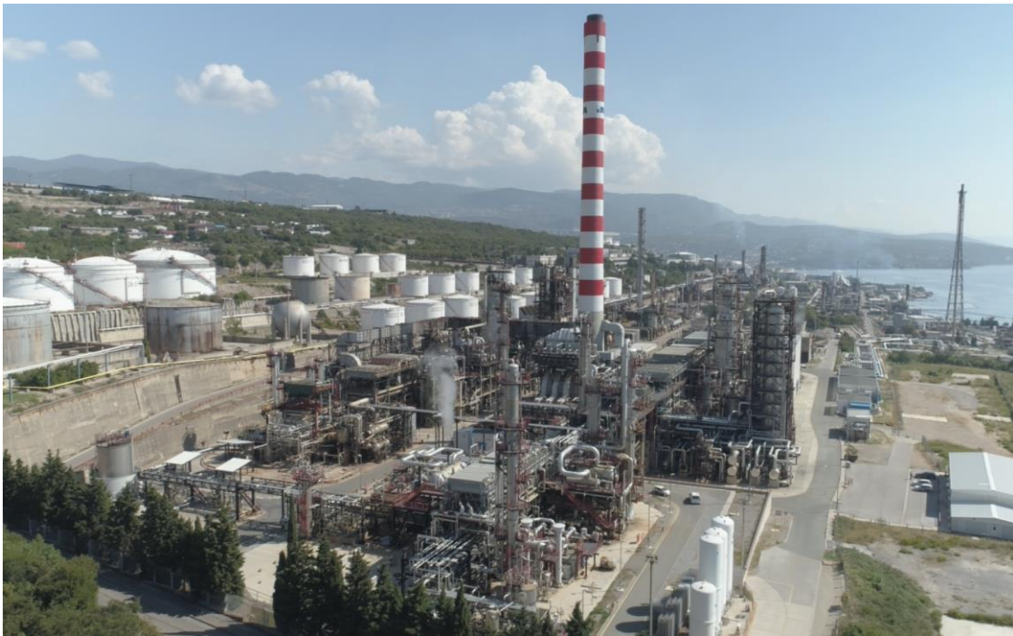
Slika 1: Pogled na postojeće postrojenje Rafinerije Urinj [2]
