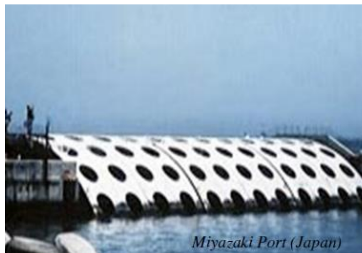
Slika 36: Polukružni kesonski lukobran [42]
