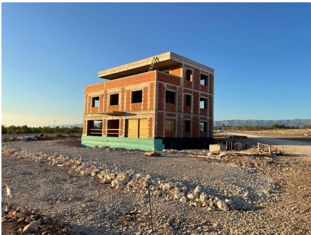
Slika 29. Gradnja upravne zgrade (izvor: snimio autor 25.08.2021)
