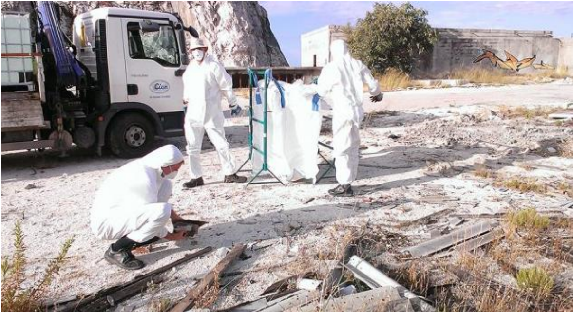
Slika 8: Prikupljanje građevinskog otpada koji sadrži azbest ( www.cian.hr )
