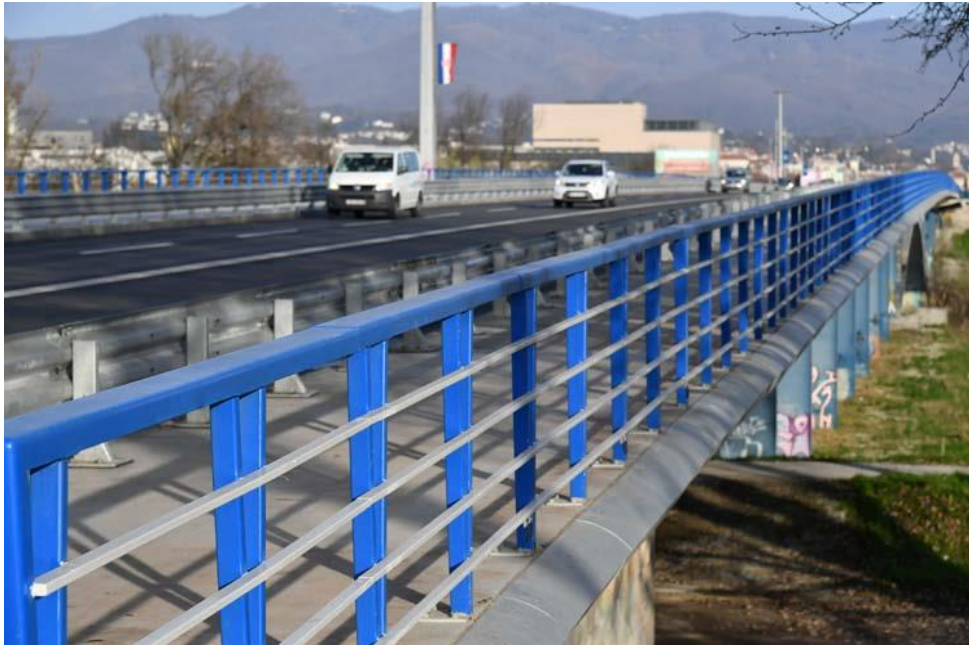
Slika 7: Most slobode nakon sanacije [21]
