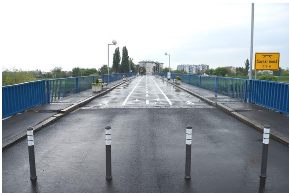
Slika 2: Savski most nakon sanacije 2017. godine [13]
