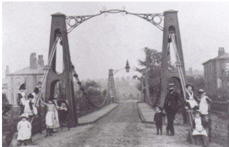
Slika 11. Obnovljeni most nakon urušavanja
