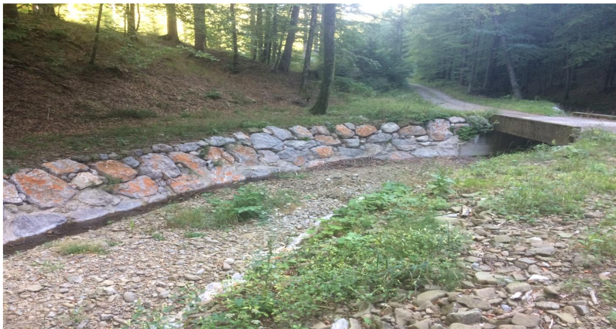
Slika 23: Zaštita pokosa krupnim kamenom –rip rap (autor izradio)
