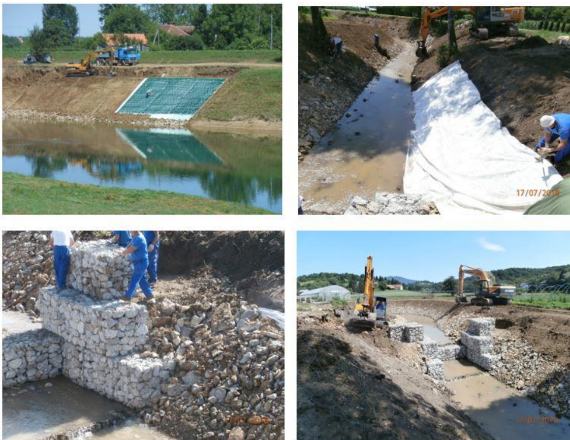
Slika 8. Prikaz korištenja i ugradnje kombinacije prirodnih i umjetnih materijala u obalu Kupe u Karlovcu te uređenja korita Malunjčice. (autorska fotografija)
