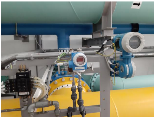
Slika 18.: Mjerenje parametara vode na izlazu iz brzih filtera, PKV Butoniga (Foto: Tamara Mošnja, 2021.)
