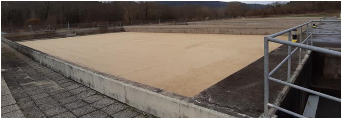
Slika 22.: Spori filter, PKV Butoniga (Foto: Tamara Mošnja, 2021.)
