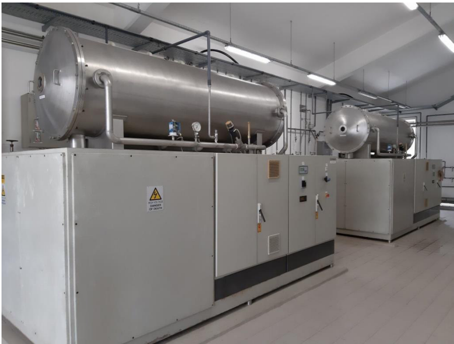
Slika 20.: Proizvodnja ozona, PKV Butoniga (Foto: Tamara Mošnja, 2021.)
