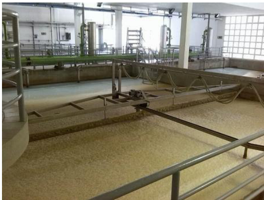
Slika 14.: Koagulacija, flokulacija i flotacija, PKV Butoniga [12]
