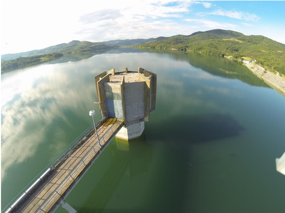
Slika 10.: Usisni toranj, akumulacija Butoniga [12]
