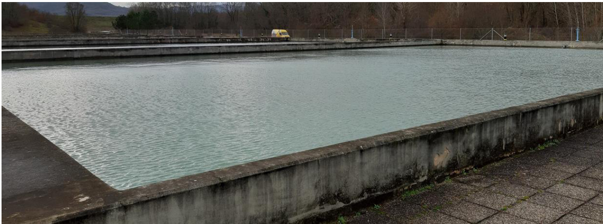
Slika 21.: Spori filter, PKV Butoniga (Foto: Tamara Mošnja, 2021.)
