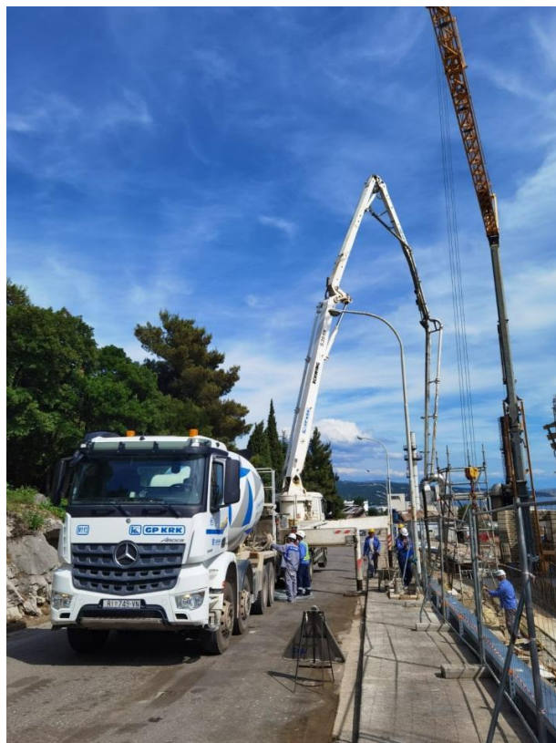
Slika 14. Prikaz ugradnje betona mobilnom pumpom
