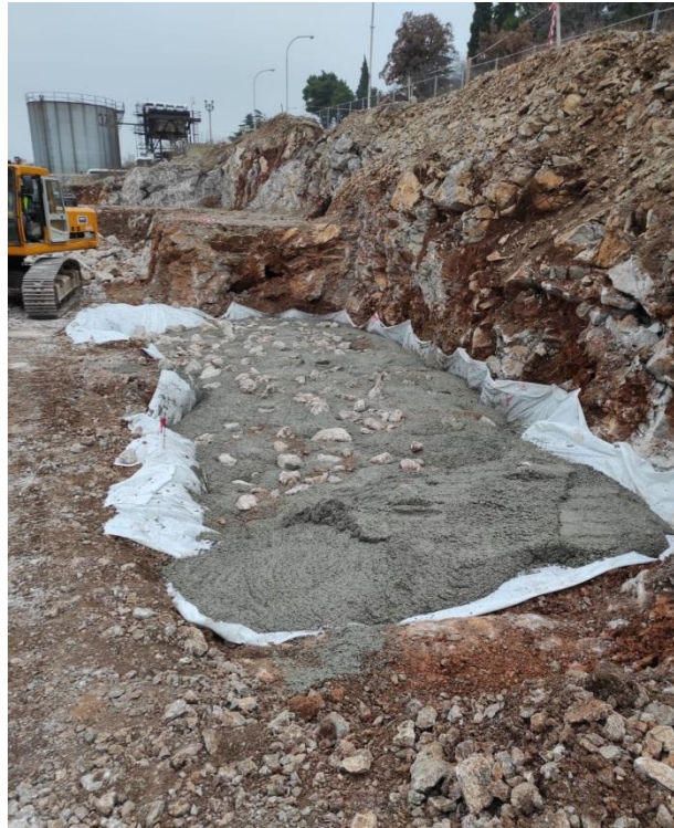
Slika 15. Izrada podložnog betona sa max. 30% kamenih blokova
