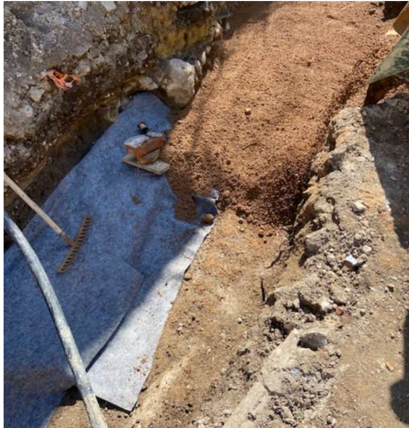
Slika 22: Zaštita nalazišta geotekstilom (fotografirao autor, 2021)
