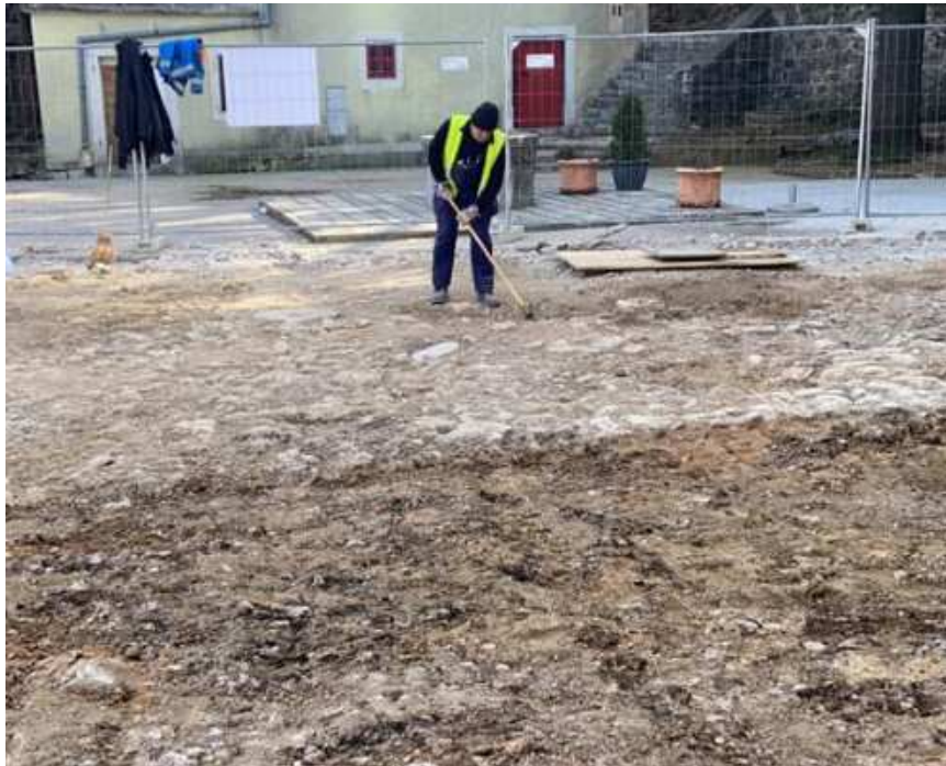
Slika 21: Ručno čišćenje pokrova cisterne (fotografirao autor, 2021)
