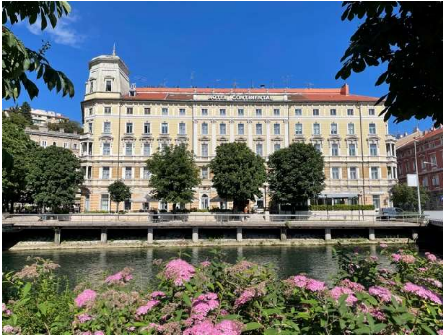
Slika 18: Slika današnjeg hotela Kontinental zapadno pročelje (Foto: autor, 2021)
