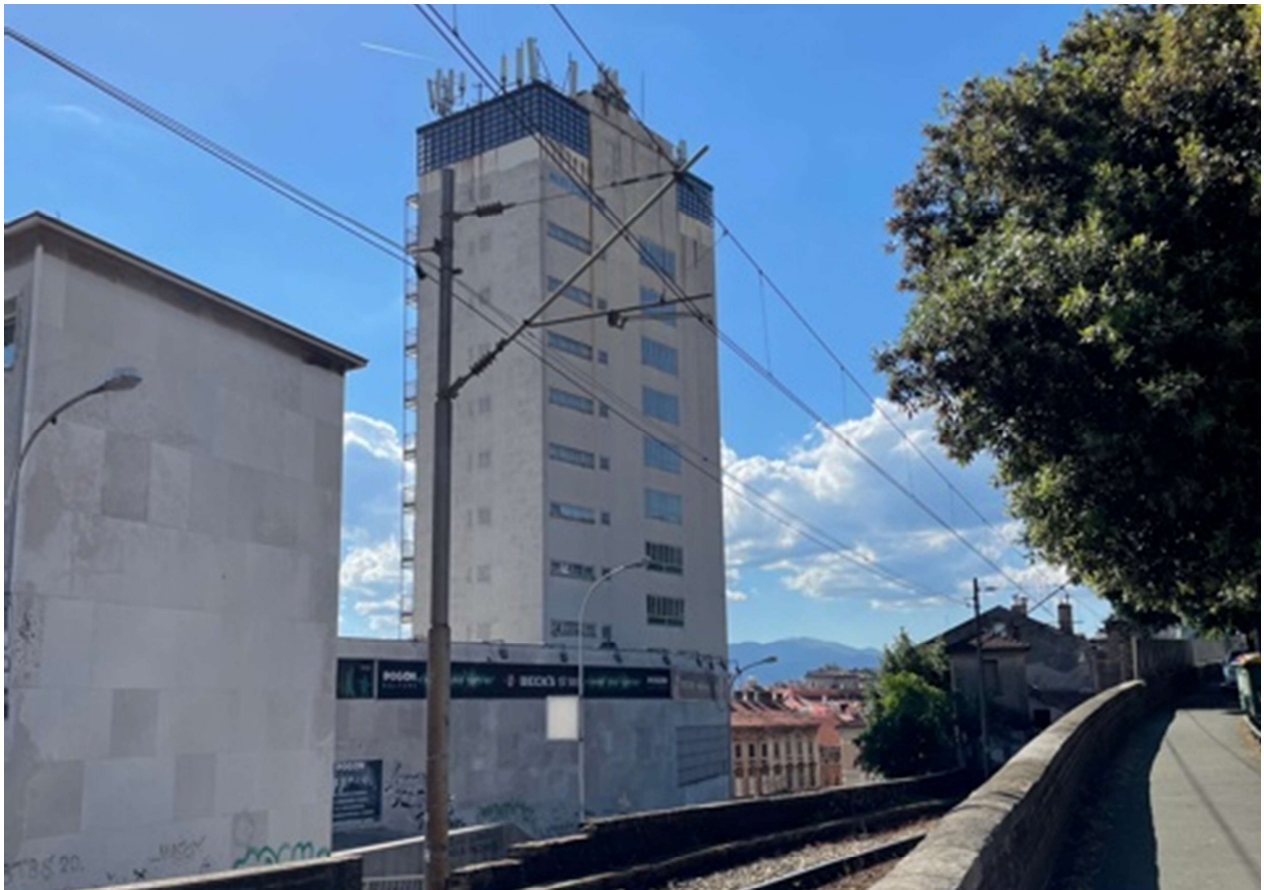
Slika 48: Slika sjeveroistočnog pročelja današnjeg hotela Neboder, (Foto: autor, 2021)
