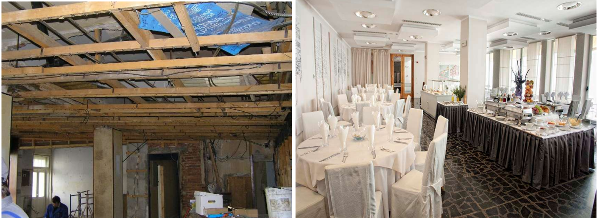
Slika 60: Restoran hotela Jadran tijekom (lijevo) i nakon rekonstrukcije (desno) (izvori: Fotodokumentacija izvođenja radova na hotelu Jadran, vlasništvo "Studia Remik" d.o.o., 2004./2005. godina, Rijeka i internet stranica hotela Jadran https://www.jadran-hoteli.hr/jadran , pristup 09.05.2021.)
