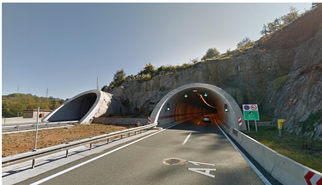
Slika 49. Prikaz portala desne cijevi tunela Grič, smjer Zagreb-Split [20]
