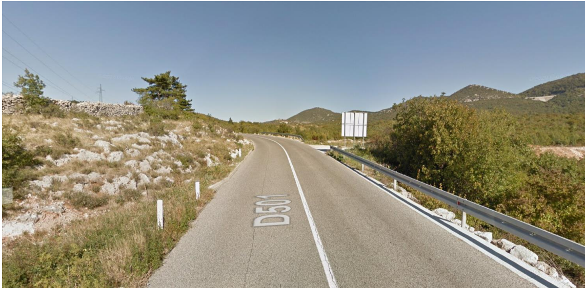
Slika 13:Lokacija budućeg raskrižja prije radova [17]
