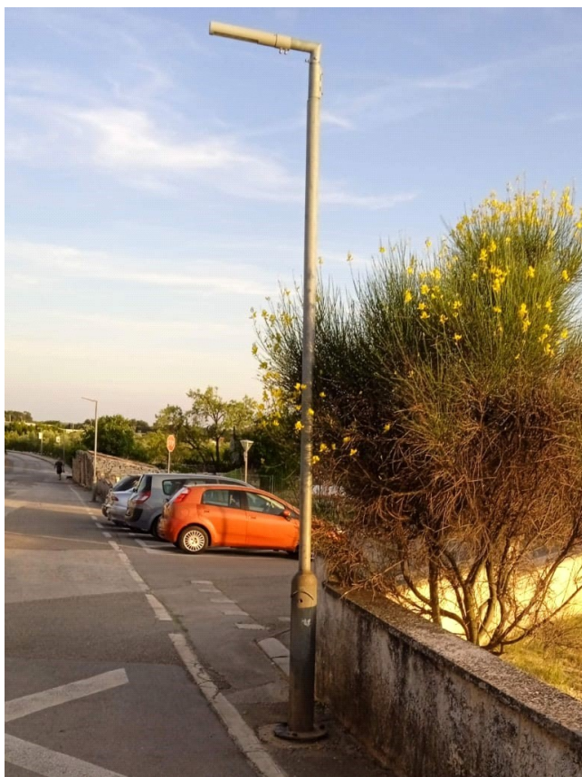
Slika 9: Čelični stup (Izradio Autor)
