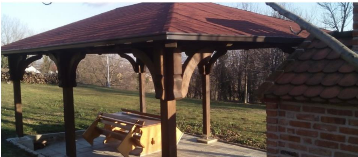
Slika 3: Nadstrešnica sa šatorastom krovnom konstrukcijom [3]
