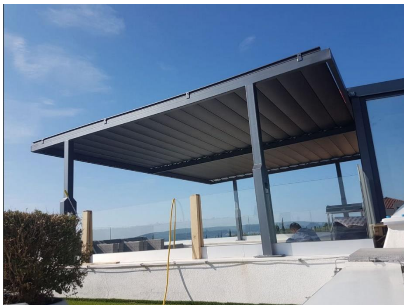
Slika 8: Primjer nadstrešnice izrađene od aluminijskih elemenata [8]
