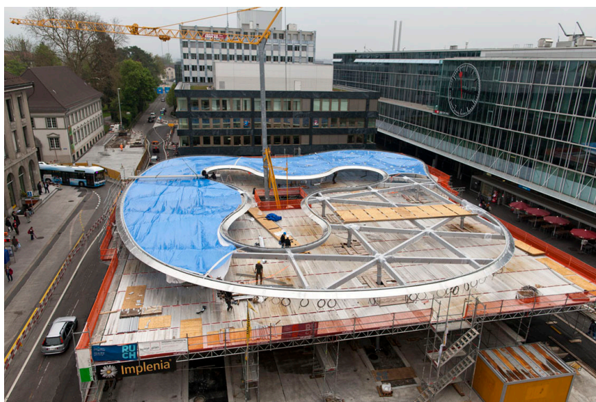
Slika 44 - Autobusni kolodvor - faza izgradnje.
