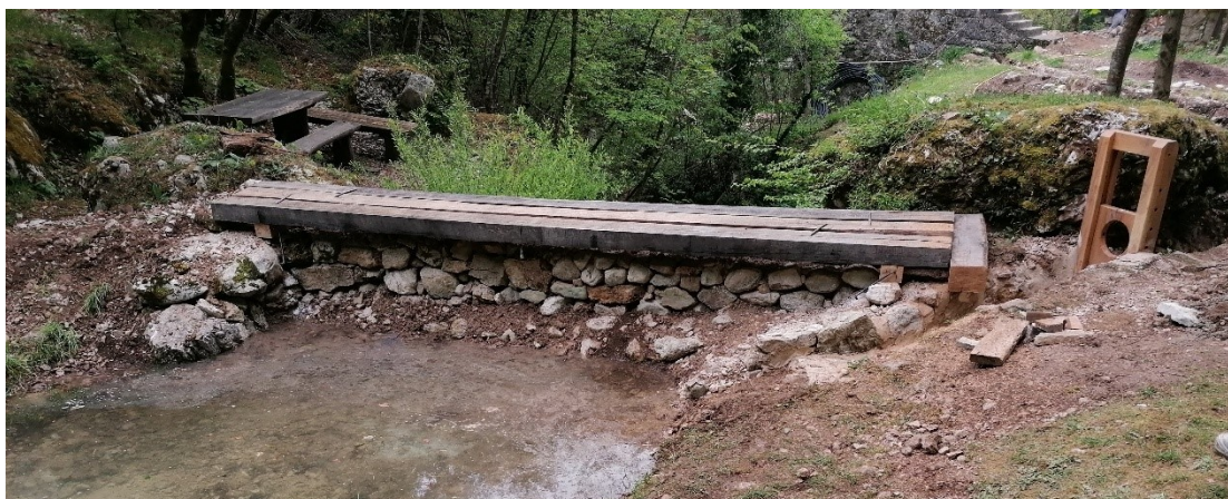
Slika 61: Izvedba brane, mostića i zapornice
