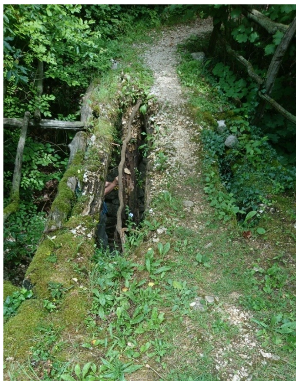
Slika 55: Drveni most ispod mlina prije rekonstrukcije
