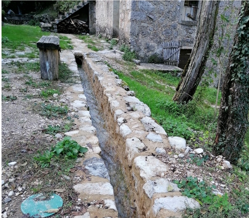
Slika 60: Rekonstruirani kameni kanal
