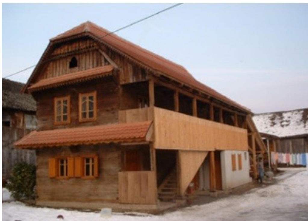
Slika 28: Stambena katnica Čigoč br. 57 nakon obnove
