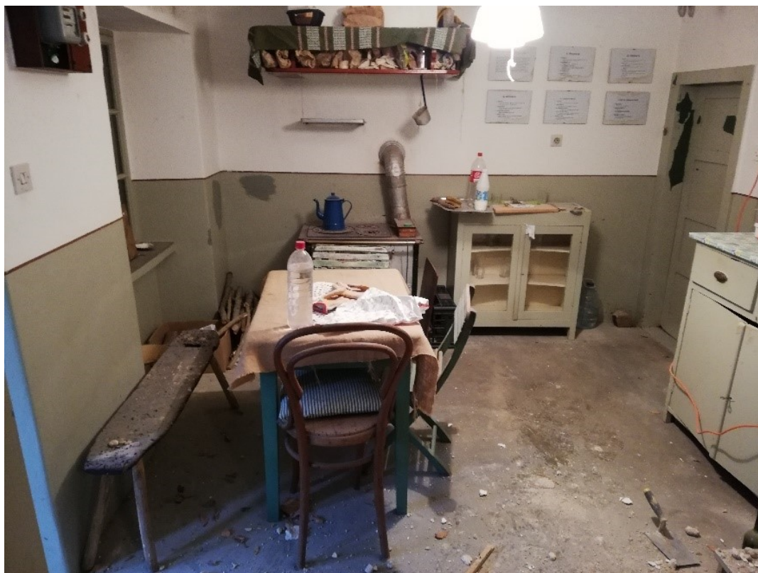
Slika 43: Prizemlje objekta prije revitalizacije
