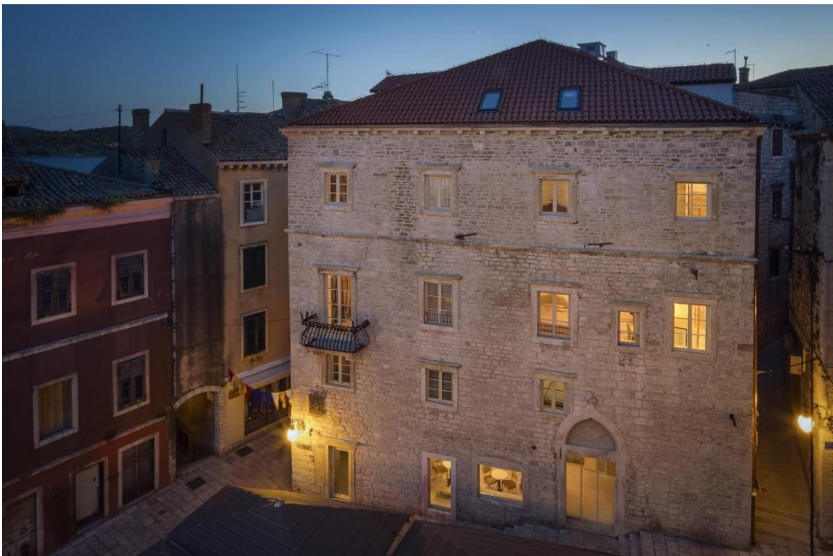
Slika 30: Palača Marenci nakon obnove u Heritage Hotel Life Palace
