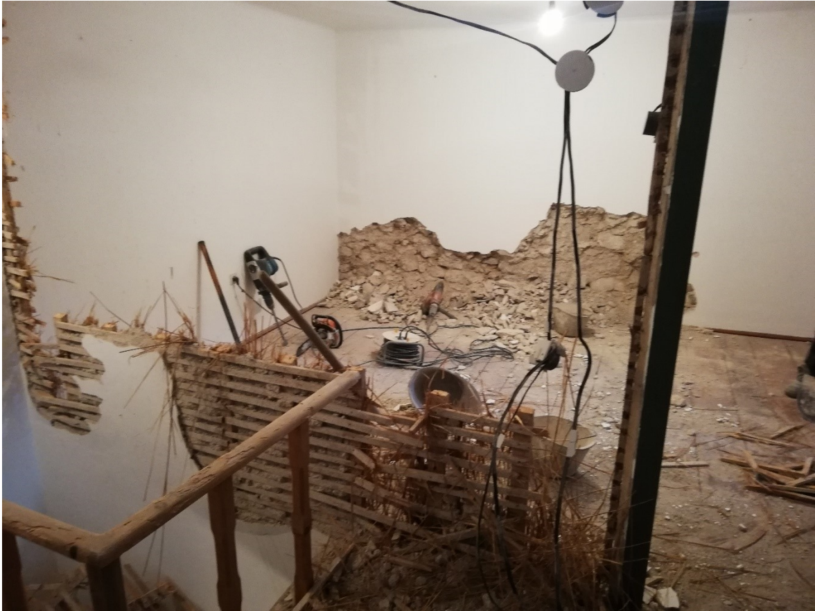
Slika 44: Pregradni zidovi objekta i daščani pod
