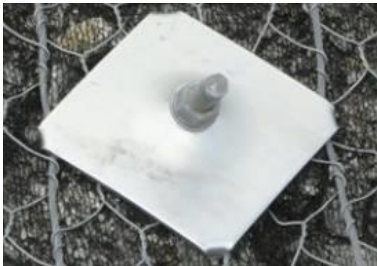
Slika 56. Čelična podložna pločica
