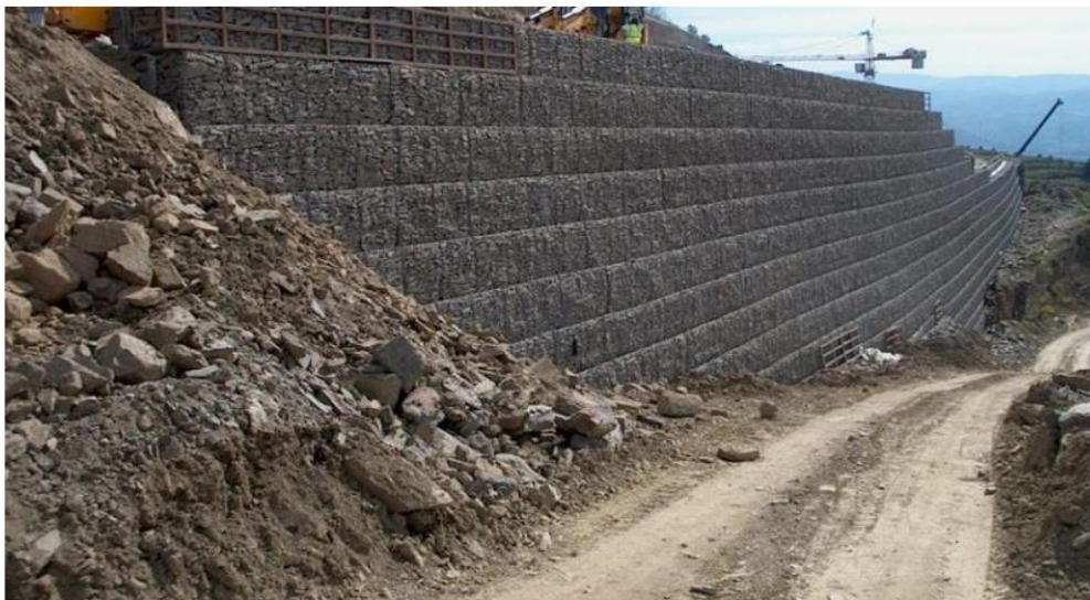
Slika 98. Primjena TERRAMESH sustava za stabilizaciju trupa prometnice
