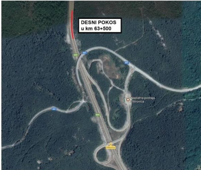
Slika 103. Lokacija pokosa na dionici autoceste A6.
