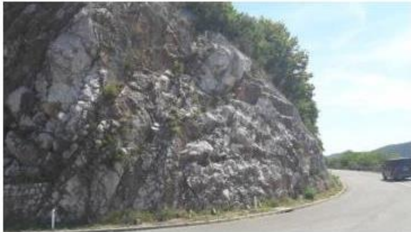
Slika 119. Predmetna kosina u sklopu inženjerskogeološkog bloka 5
