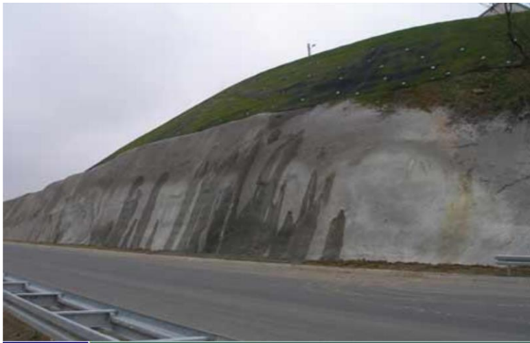
Slika 65. Zaštita pokosa mlaznim betonom
