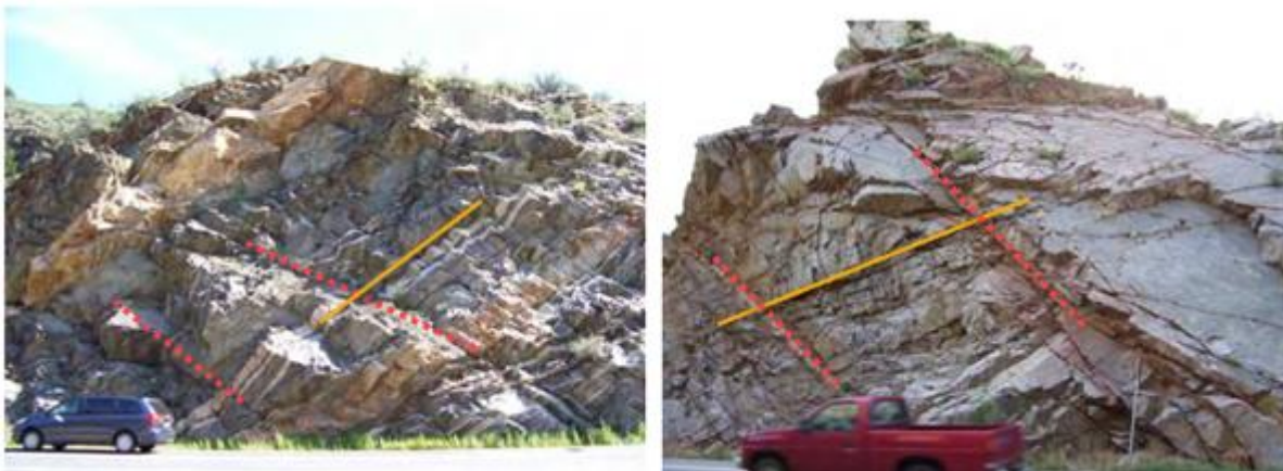
Slika 26. Diskontinuiteti – postojanost i orijentacija
