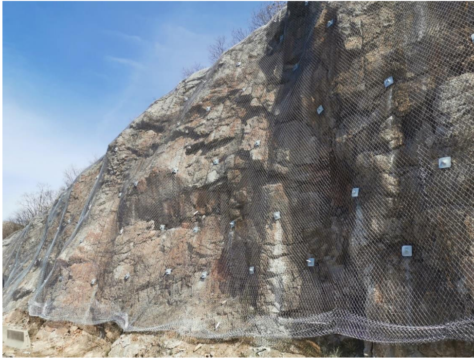
Slika 40. Primjer mjere sanacije pokosa
