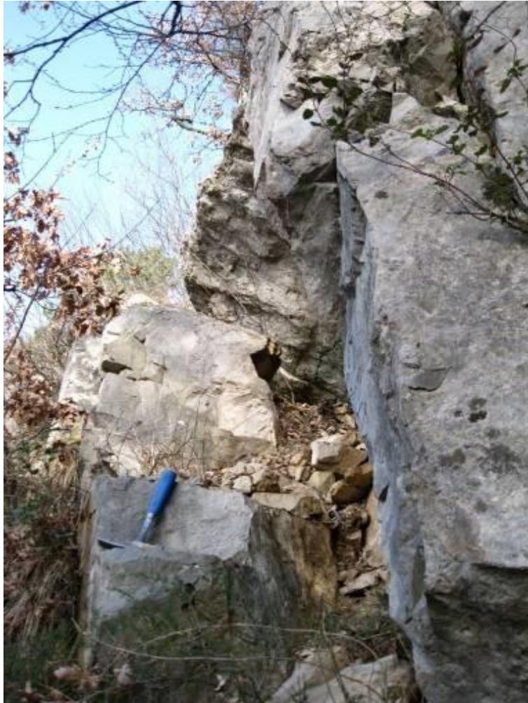
Slika 129. Blok obujma 1\text{m}^3 u potpunosti odvojen od stijene pukotinom orijentacije 30/85 (Grošić 2012)
