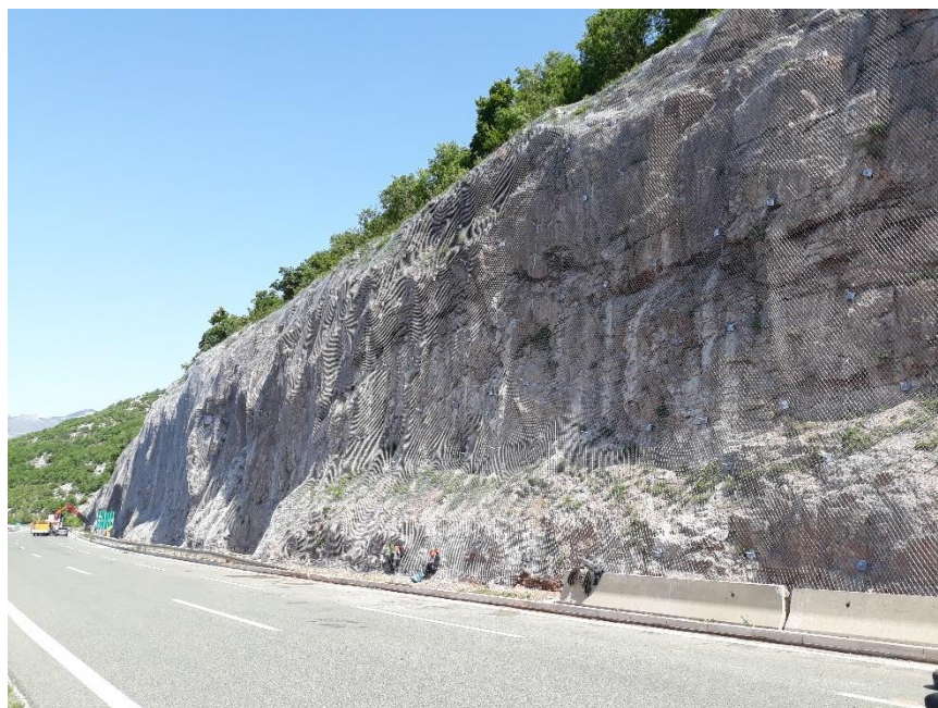
Slika 61. Primjer korištenja 3STUTOR mreže za zaštitu pokosa
