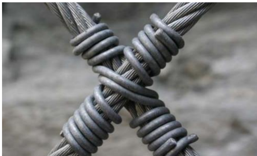
Slika 53. Patentirani dvostruki čvor - HEA
