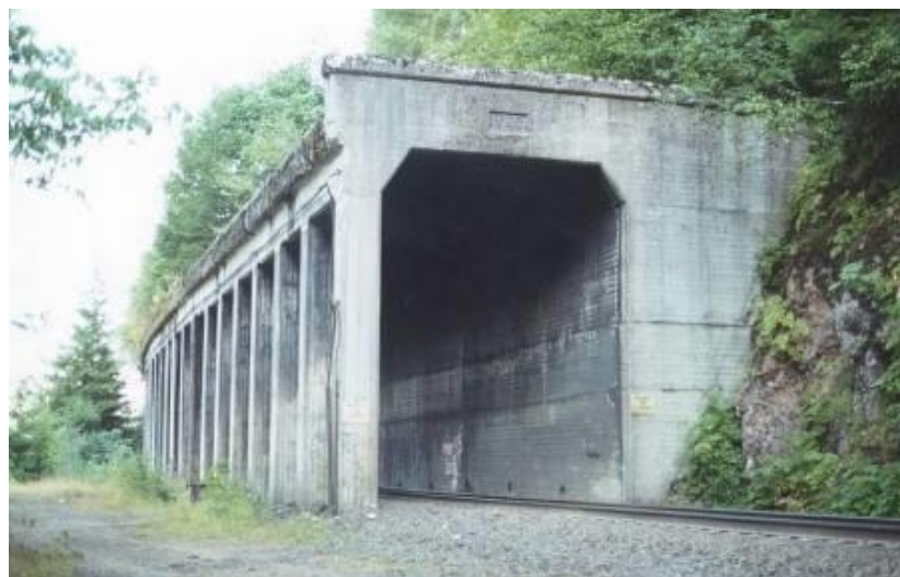
Slika 90. Konstrukcija za zaštitu od odrona – galerija
