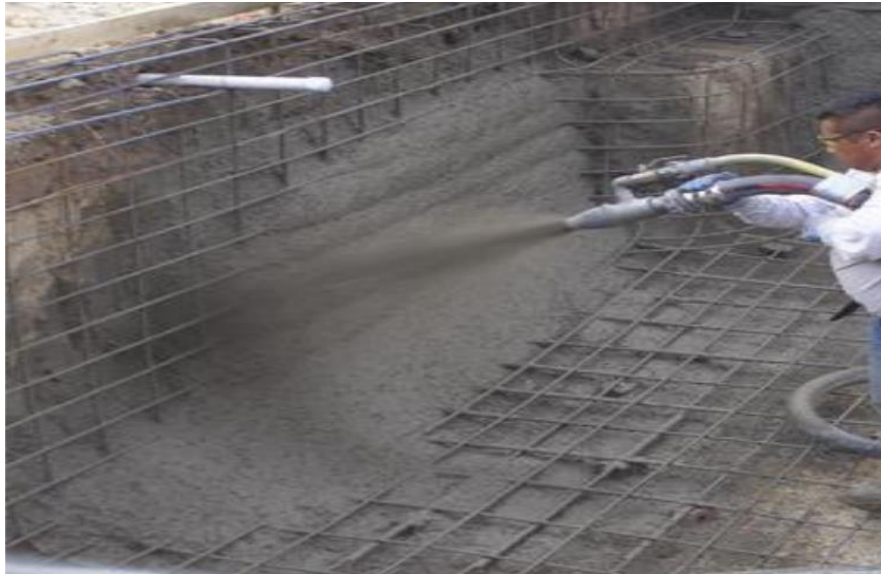
Slika 68. Ugradnja mlaznog betona armiranog čeličnom mrežom
