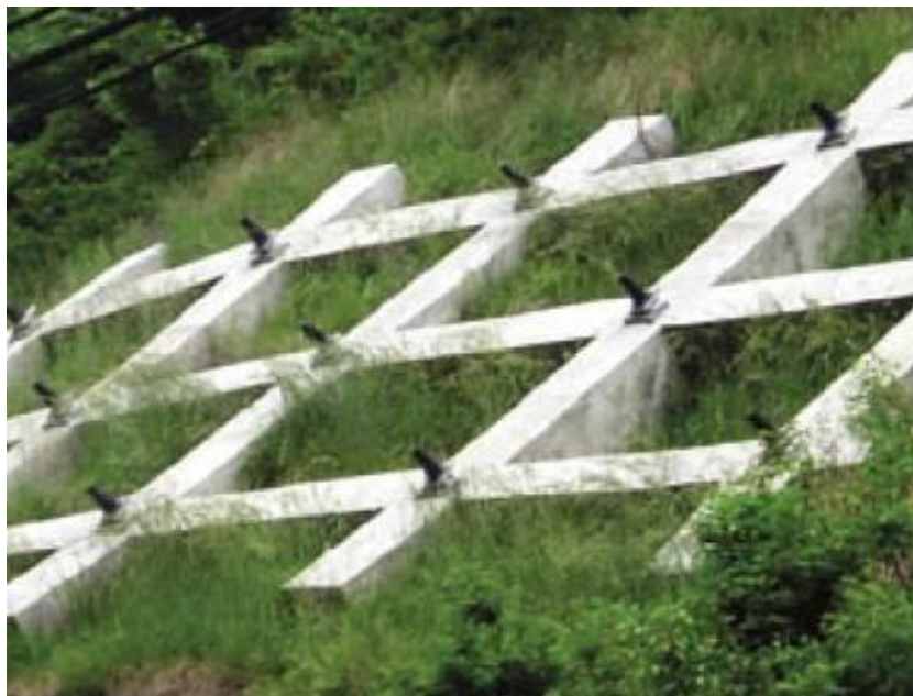
Slika 87. Potporna roštiljna konstrukcija u kombinaciji sa sidrima
