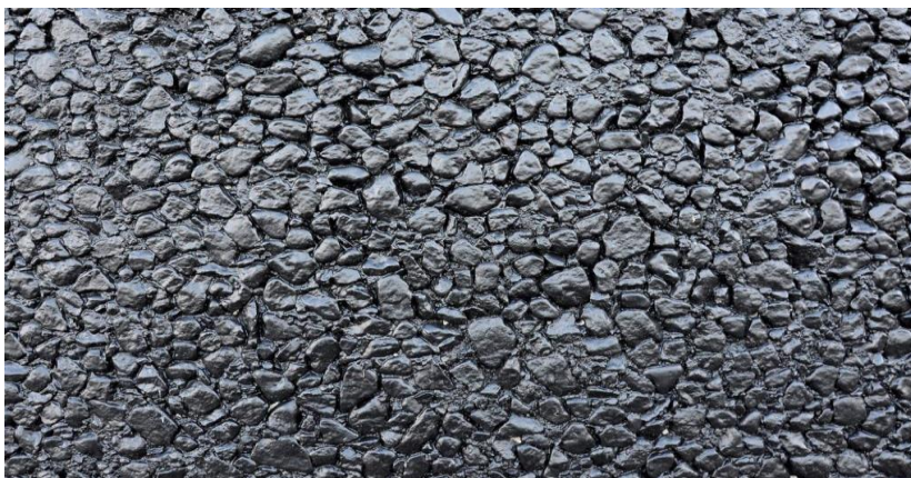
Slika 15: Površinska tekstura ugrađenog SMA asfalta [15]
