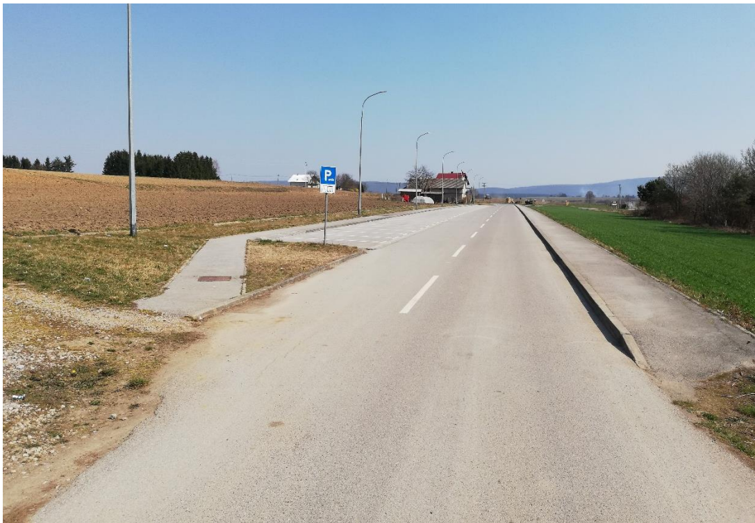
Slika 31: Mjesto spoja neuređenog i uređenog dijela postojeće ceste
