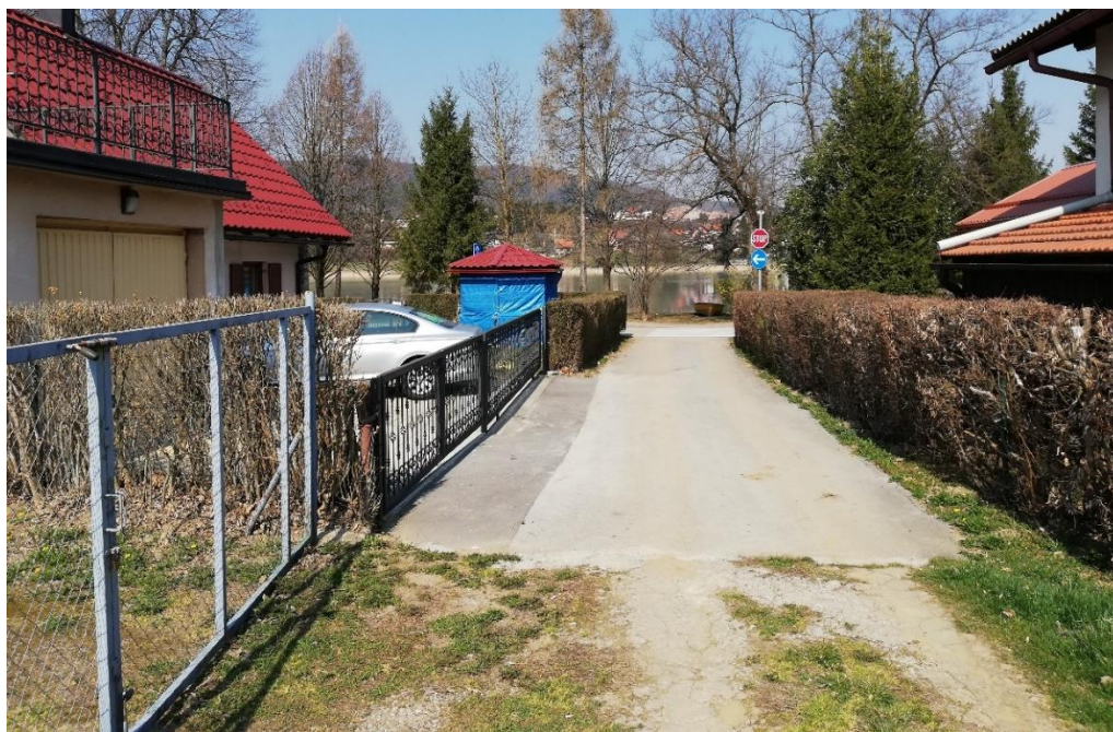
Slika 23: Započeta staza koja spaja obalnu i novu sabirnu cestu – pogled prema obalnoj cesti
