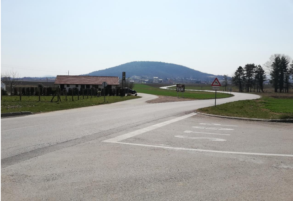
Slika 11: Postojeći spoj sabirne ceste, ŽC 3218 i prilaza kampu
