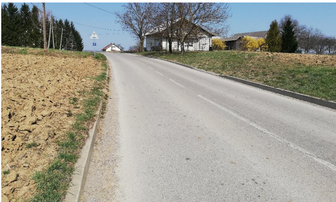
Slika 7: Postojeće stanje ŽC 3218
