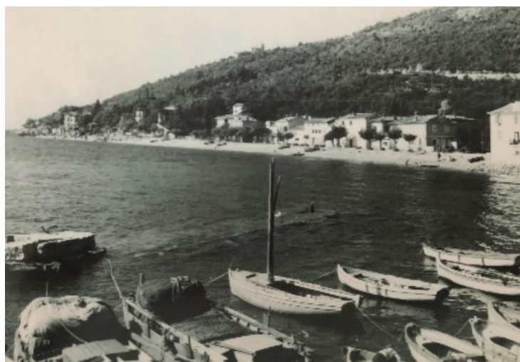
Slika 3: Lukobran u izgradnji 1960. godine [2]
