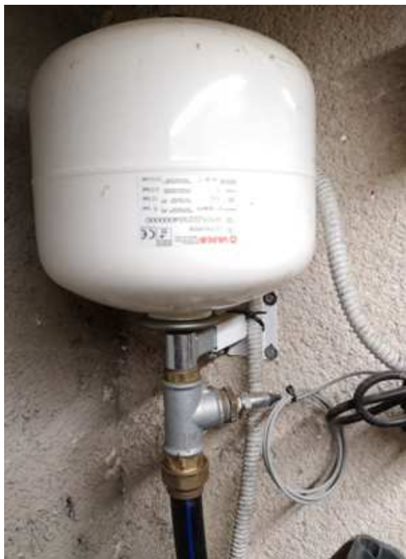
Slika 6: Membranska posuda pod tlakom s ugrađenim tlačnim prekidačem
