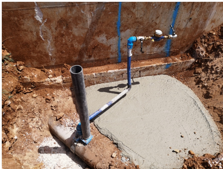
Slika 7: Priključak na javni vodovod
