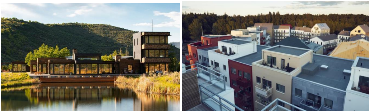
Slika 26, 27: Ravni krovovi na stambenim zgradama od armiranog betona
