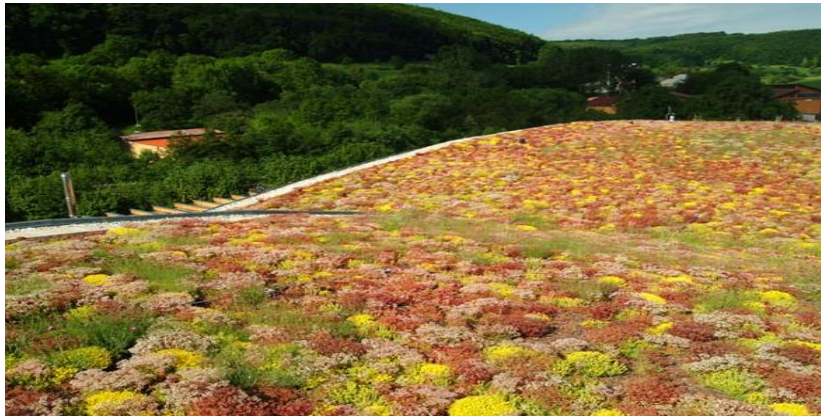
Slika 8: Izgled ekstenzivnog zelenog krova
