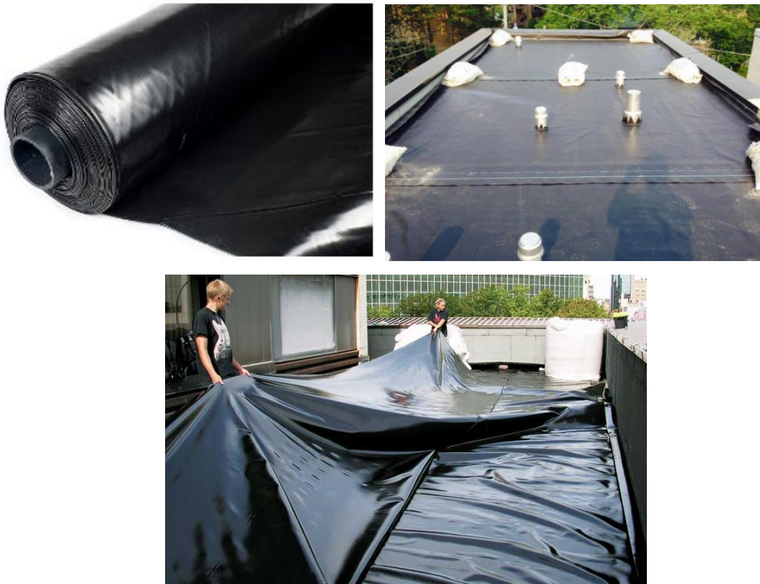
Slika 43, 44, 45: Zaštitni sloj zelenih krovova od korijenja
