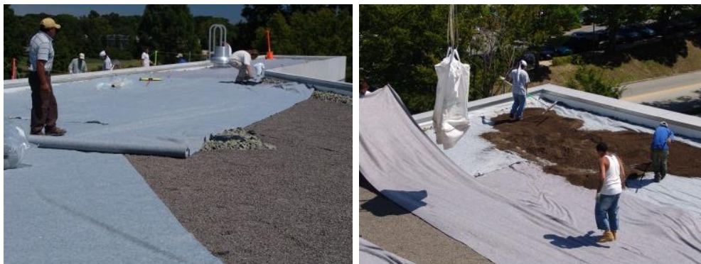
Slika 33, 34: Postavljanje filtarskog sloja
