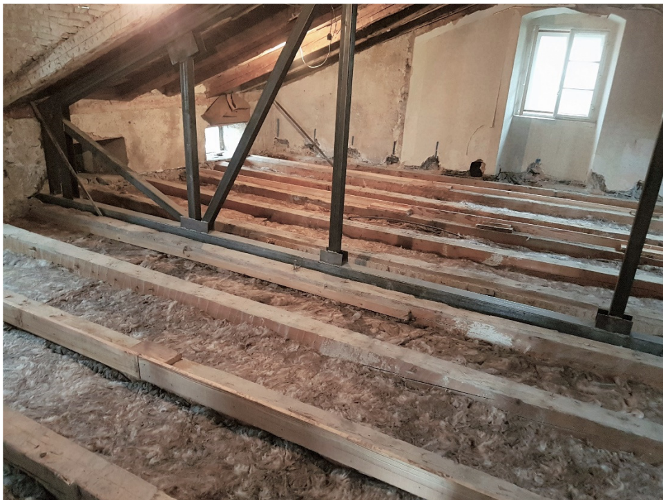
Slika 31: Drveni gređnik (foto autor)
