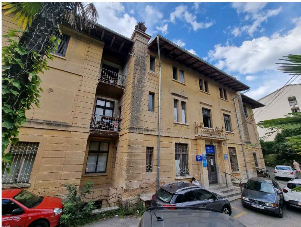
Slika 29: Sjeverno pročelje Doma zdravlja (foto autor)
