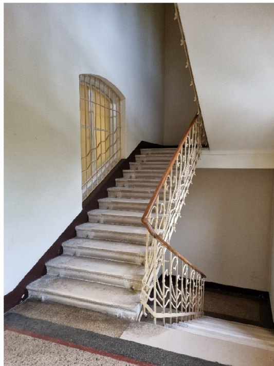
Slika 33: Kameno dvokrako stubište (foto autor)
