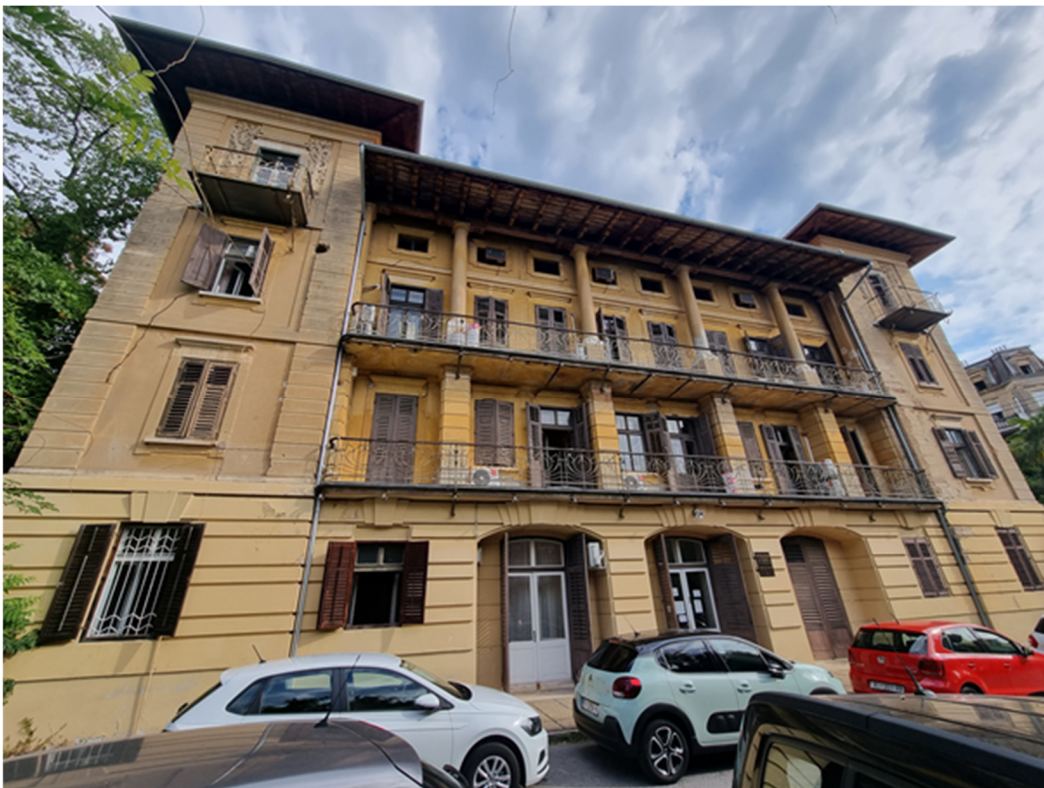
Slika 28: Južno pročelje zgrade Doma zdravlja (foto autor)
