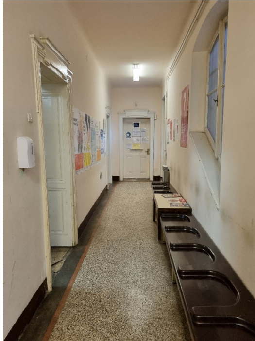
Slika 32: Brušeni Teraco pod (foto autor)
