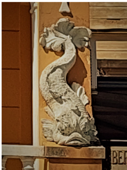
Slika 7: Detalj ukrasa na pročelju (foto autor)
