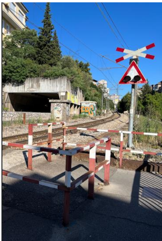
Slika 13: Uređaji sa svjetlosno-zvučnim signalima [foto autor]
