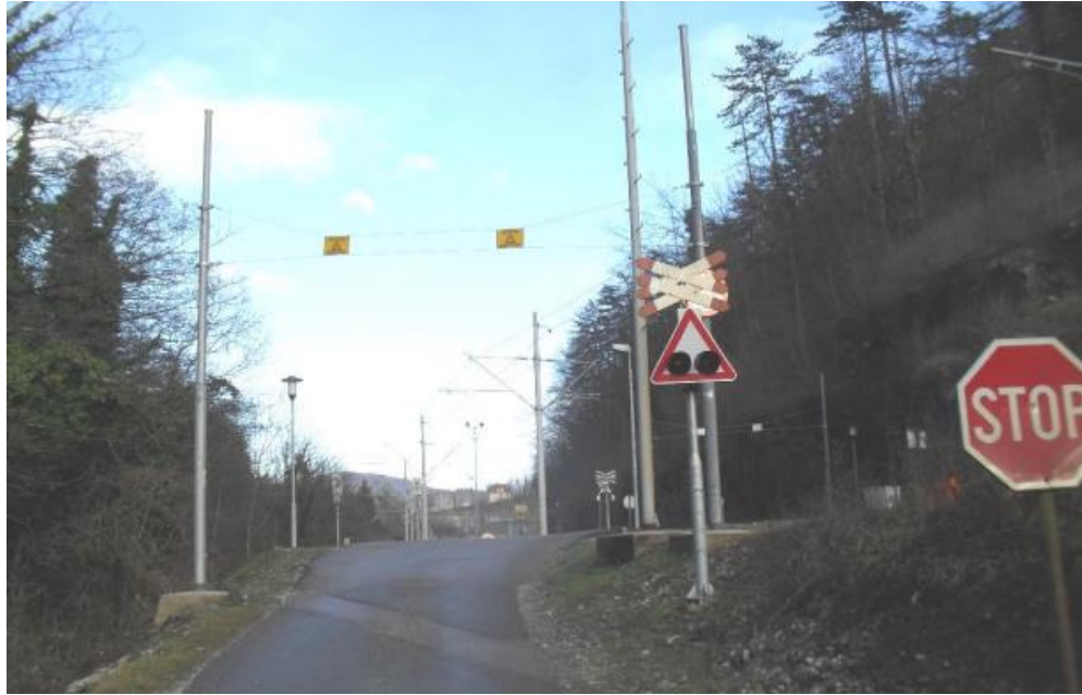
Slika 21: Željezničko cestovni prijelaz „Kamačnik“ smjer Rijeka-Zagreb preuzeto iz [8]
