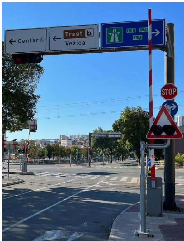
Slika 12: Uređaji sa svjetlosno-zvučnim signalima i polubranicama [foto autor]
