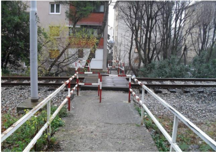
Slika 22: Pješački prijelaz preko pruge „Kantrida“ [foto autor]
