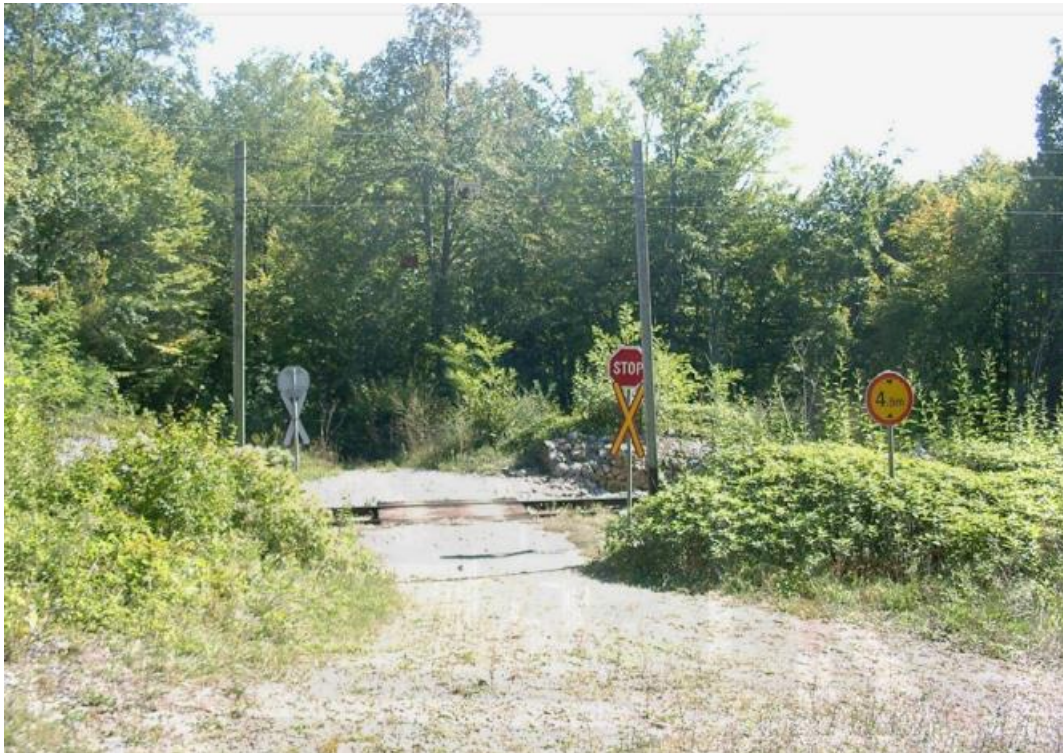
Slika 24: Željezničko-cestovni prijelaz „Brgud“ preuzeto iz [8]
