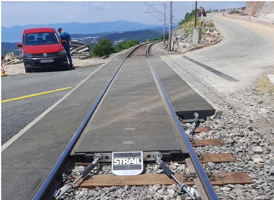
Slika 19. Prikaz podloge na željezničko-cestovnom prijelazu „Meja-Milja“ preuzeto iz [8]
