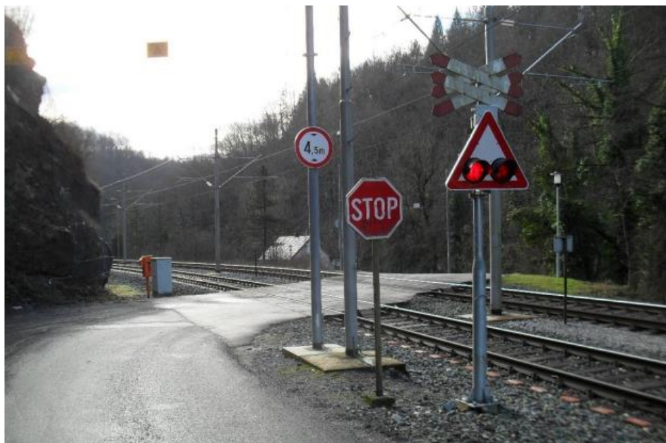
Slika 20: Željezničko cestovni prijelaz „Kamačnik“ smjer Zagreb - Rijeka preuzeto iz [8]
