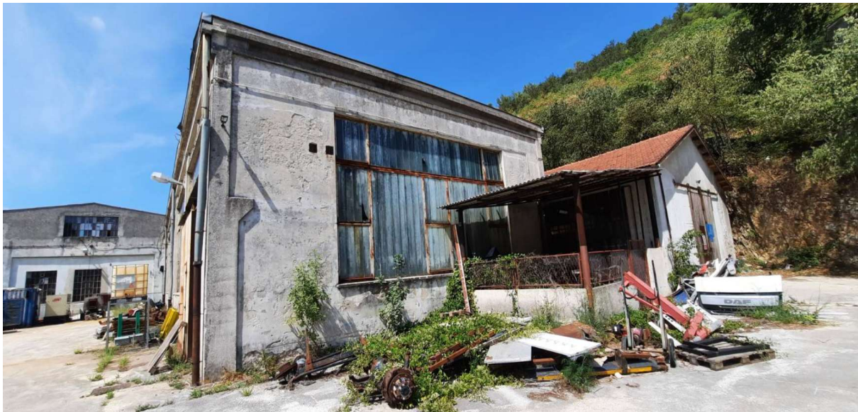
Slika 55.: Istočna pročelja zgrada kompleksa Prvomajske
