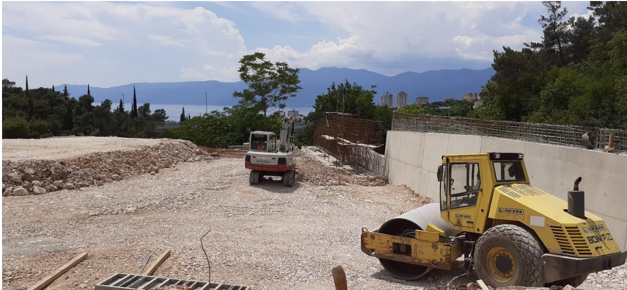
Slika 13. Prikaz izrade nasipa
