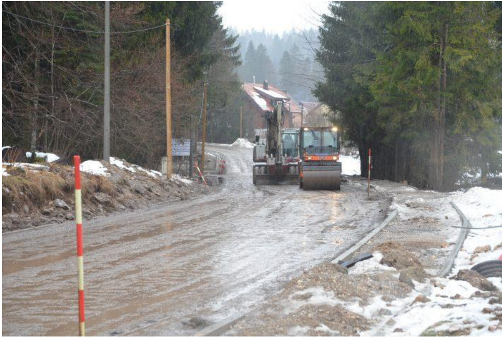
Slika 48. Uvjeti na gradilištu (fotografija autora)
