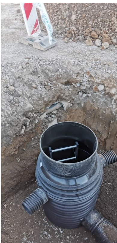
Slika 28. PE okno DN800 (fotografija autora)
