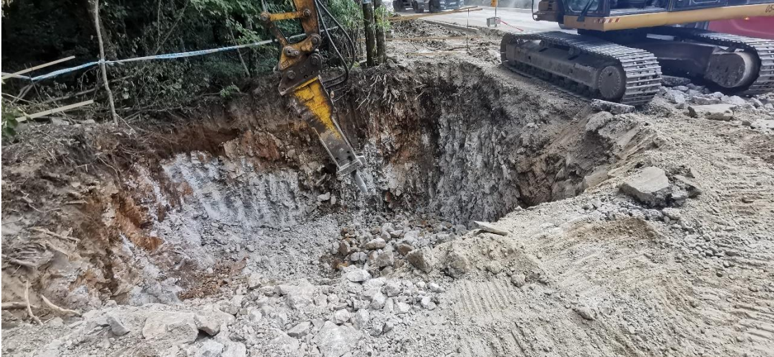
Slika 22. Iskop upojnog bunara (fotografija autora)
