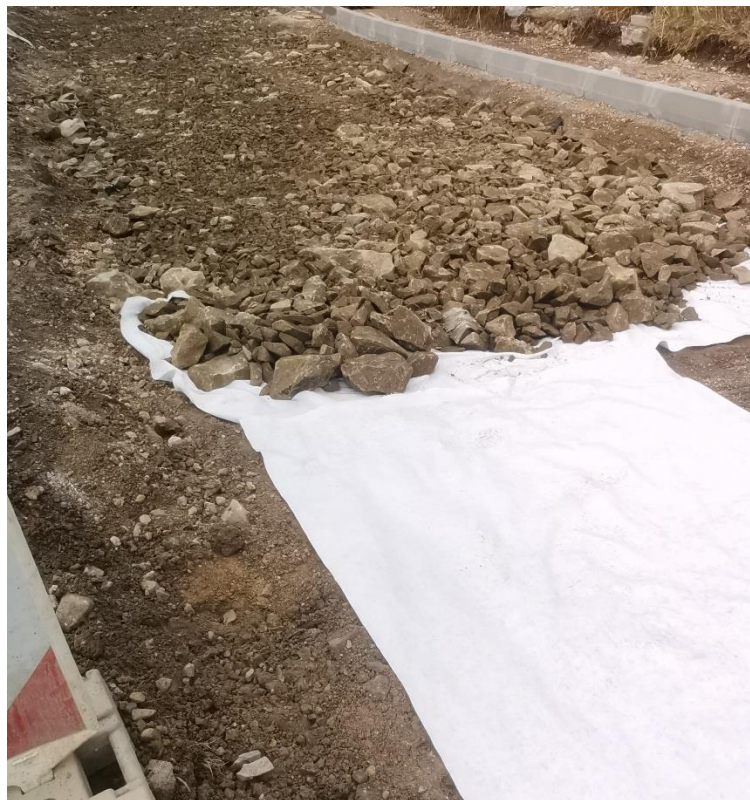
Slika 38. Postavljanje geotekstila za razdvajanje slojeva (fotografija autora)
