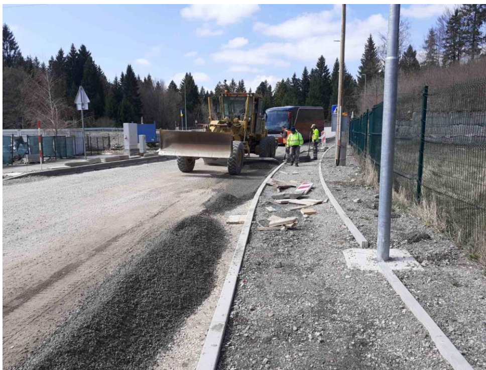
Slika 40. Razastiranje i planiranje tamponskog sloja (fotografija autora)
