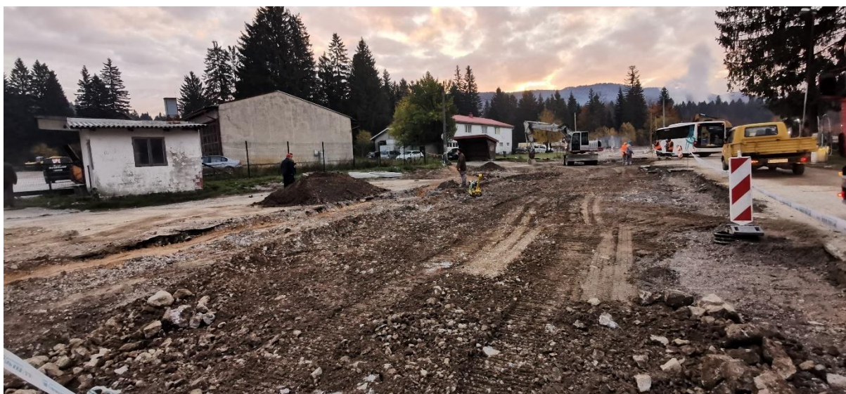
Slika 49. Izvedba proširenja prometnice (fotografija autora)
