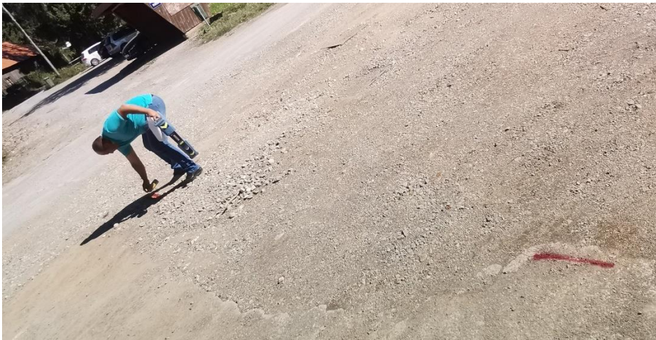
Slika 32. Lociranje postojećih kabela (fotografija autora)
