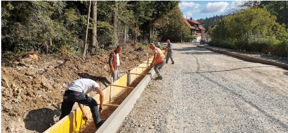
Slika 45. Način izvođenja radova nakon dogovora izvođača i investitora (fotografija autora)
