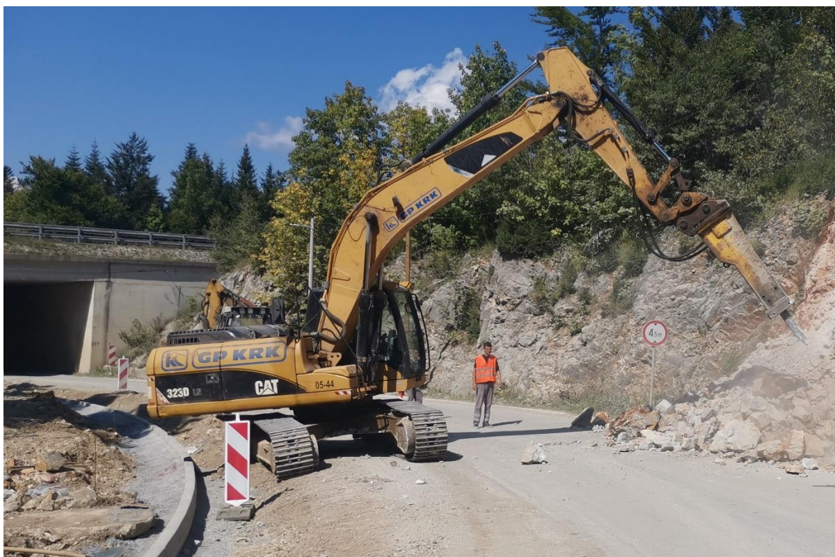
Slika 14. Stabiliziranje pokosa (fotografija autora)
