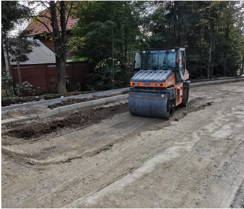
Slika 37. Zbijanje temeljnog tla (fotografija autora)
