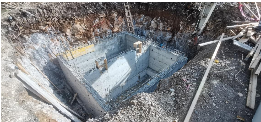
Slika 19. Izvođenje zidova upojnog bunara (fotografija autora)
