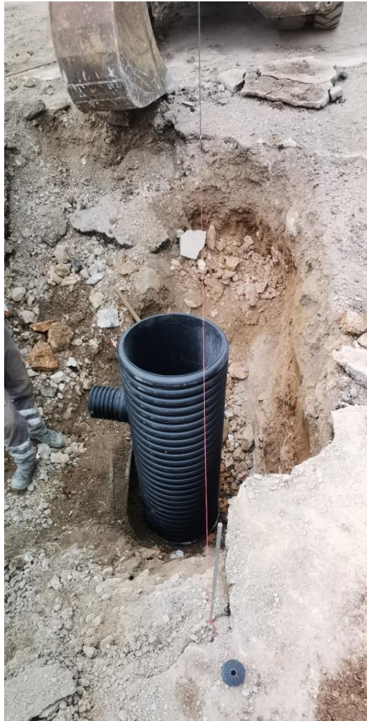
Slika 31. Slivnik DN500 (fotografija autora)
