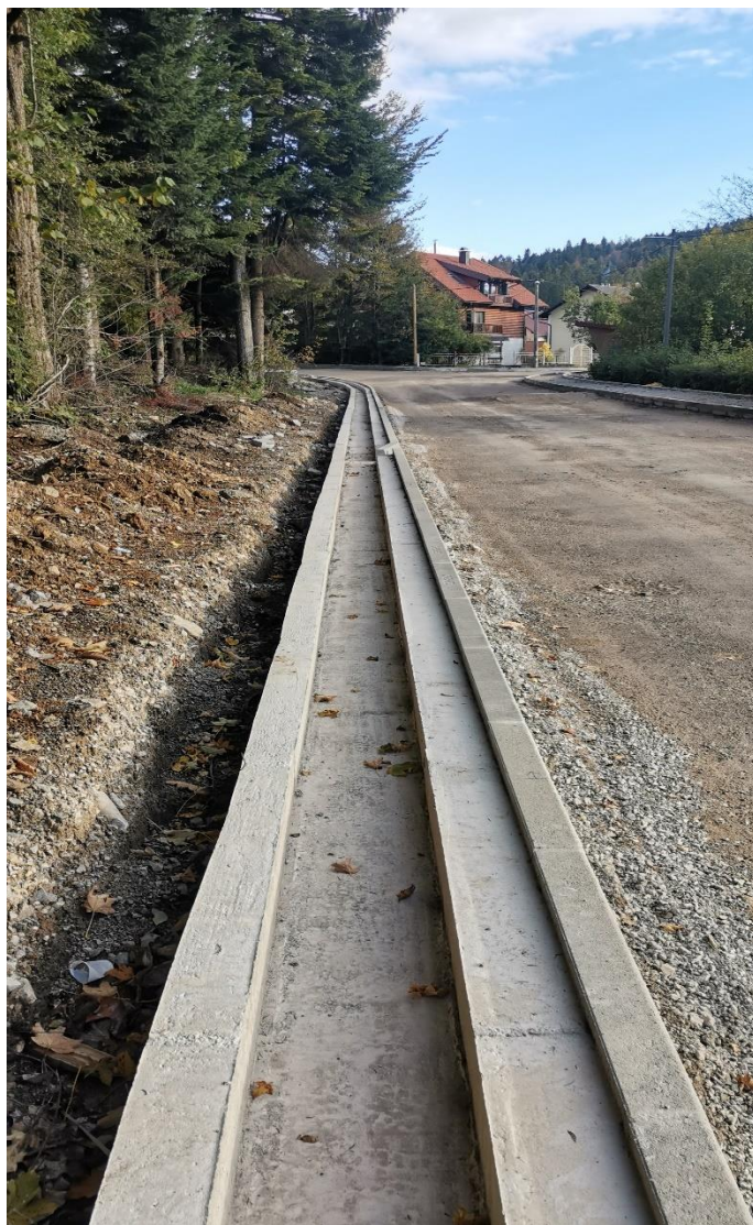
Slika 16. Izvedeni betonski jarak (fotografija autora)
