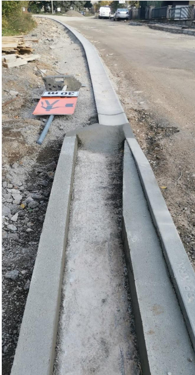
Slika 17. Predgotovljeni betonski elementi jarka (fotografija autora)
