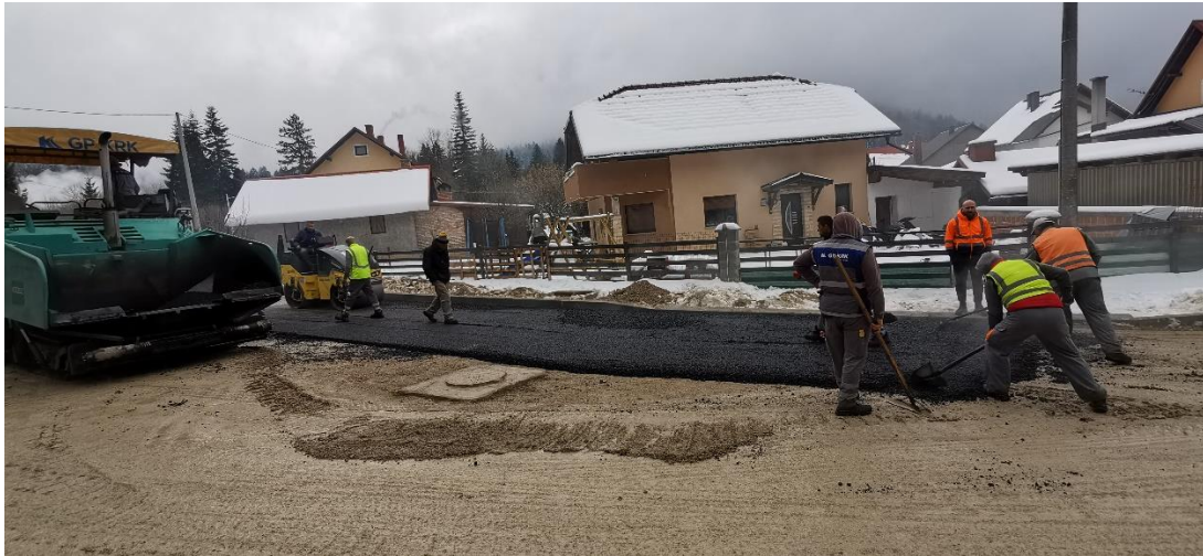
Slika 55. Ugradnja asfaltnog sloja pri lošim vremenskim uvjetima (fotografija autora)
