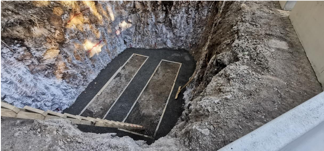
Slika 20. Izvođenje podložnog betona ispod temelja (fotografija autora)
