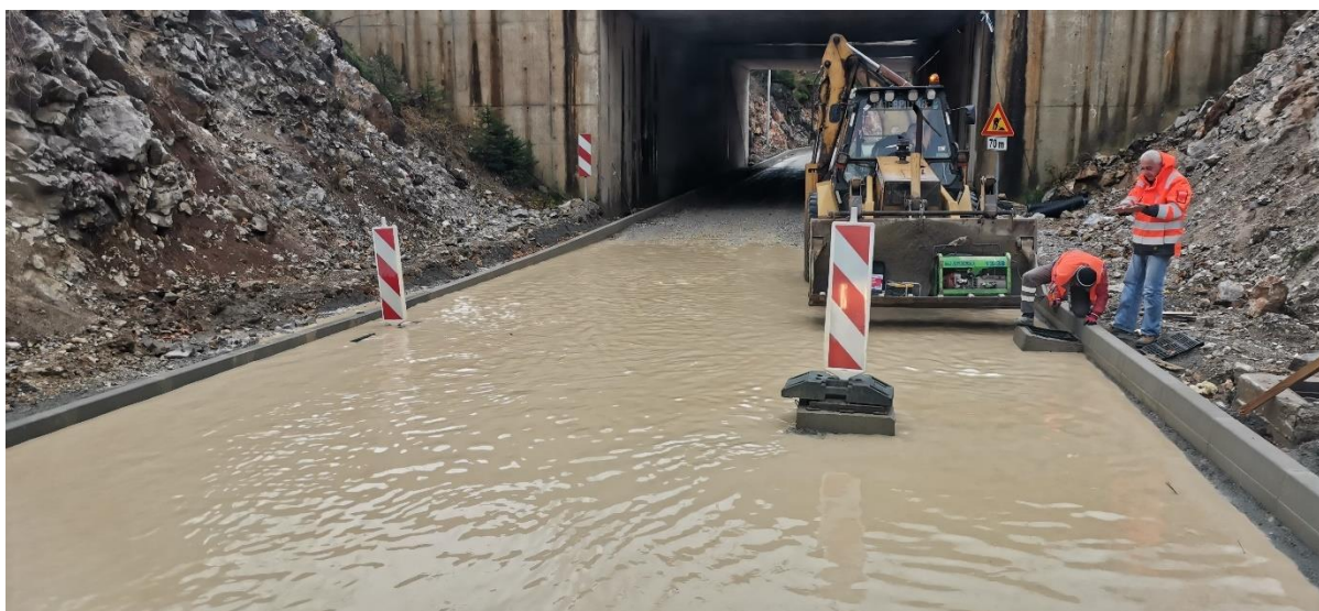
Slika 50. Začepljenje oborinske kanalizacije na najnižoj koti prometnice, dubina vode preko 0,5 m (fotografija autora)
