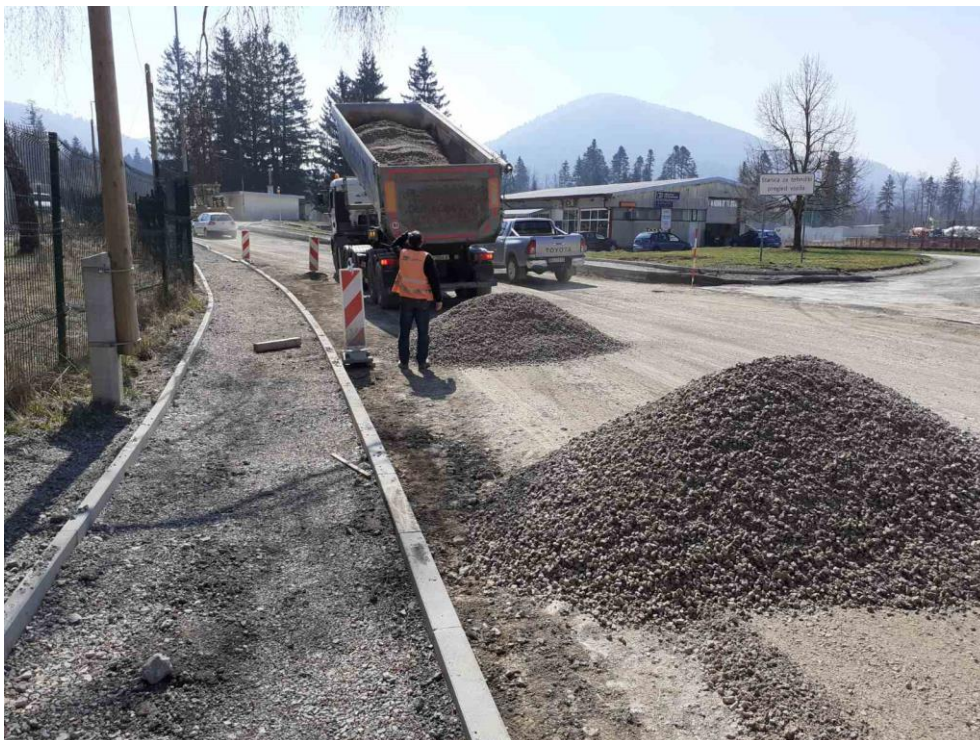
Slika 39. Nasipavanje tamponskog sloja (fotografija autora)
