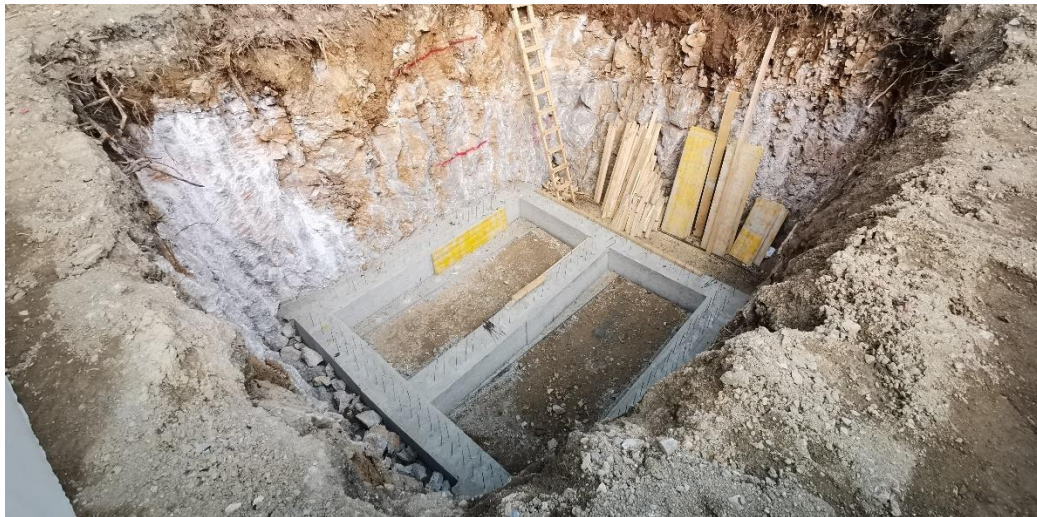
Slika 21. Izvedeni temelji (fotografija autora)
