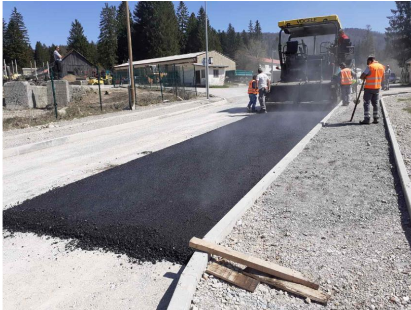
Slika 42. Ugradnja asfaltne mješavine (fotografija autora)
