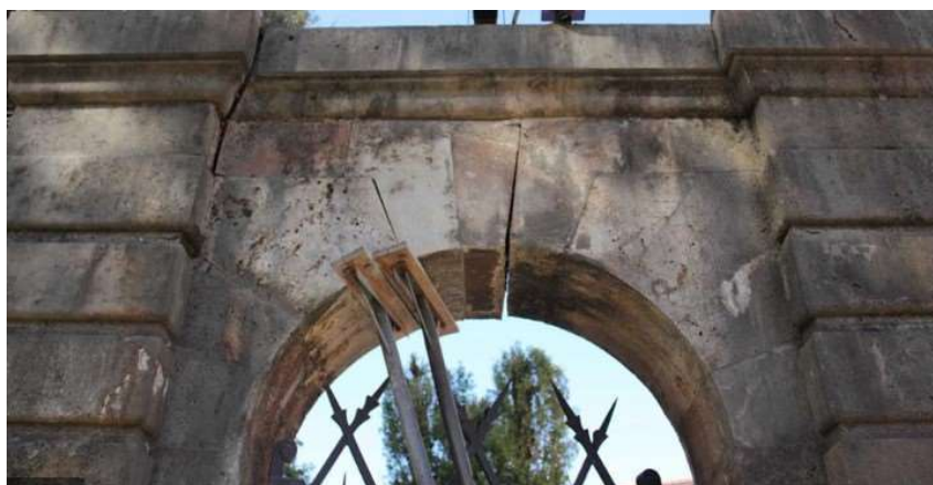
Slika 13. Pojava zgloba na lučnoj konstrukciji [7]
