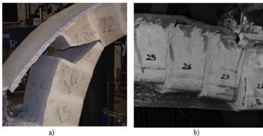
Slika 21. a) Odvajanje + drobljenje, b) posmično klizanje + odvajanje [5]
