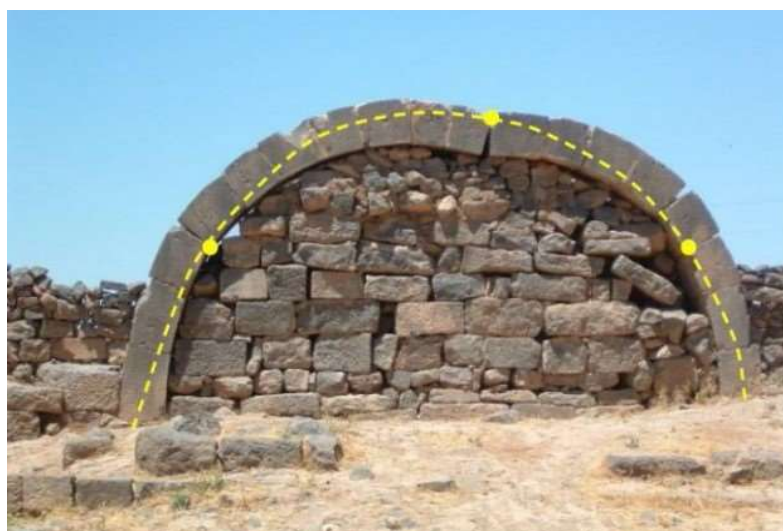
Slika 12. Pojava zglobova uz prikaz potporne linije [7]
