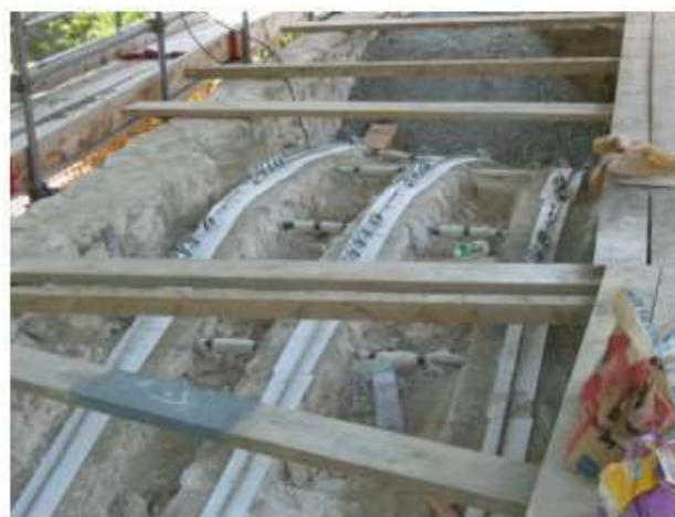
Slika 43. Postavljanje RAM kablova na ekstradosu luka [7]
