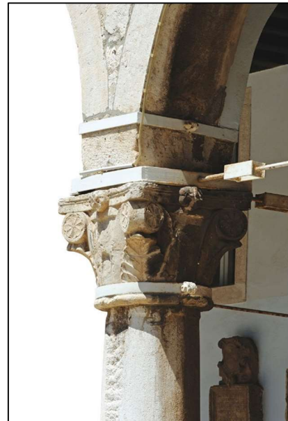
Slika 16. Tehnika sa zategama na objektu Komunalne palače u Puli
