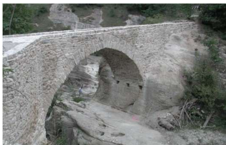
Slika 44. Izgled obnovljenog mosta [7]
