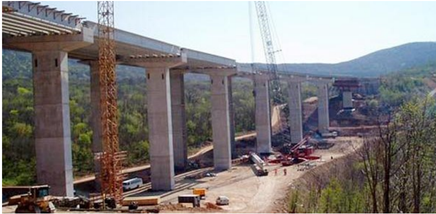
Slika 1. Vijadukt Bukovo na autocesti Rijeka – Zagreb [4]
