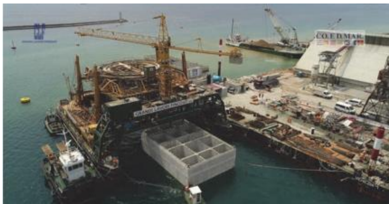
Slika 38. Plutajuće postrojenje za izvedbu kesona [52]
