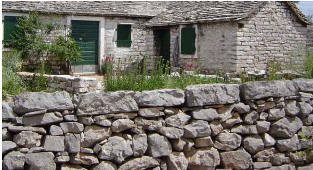
Slika 7. Prikaz suhozida i kuće od kamena sa vezivnim sredstvom [8]
