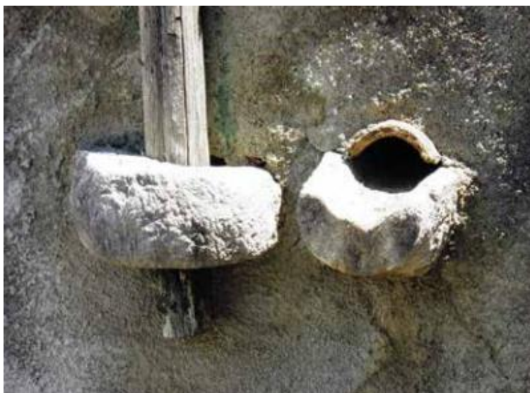
Slika 32. Prikaz šuplje kamene konzole i „rigalice“ [2]
