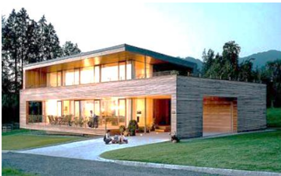
Slika 54. Prikaz kuće izgrađene od drveta [26]
