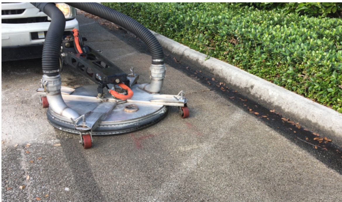
Slika 13: Čišćenje procjdnog betona [8]
