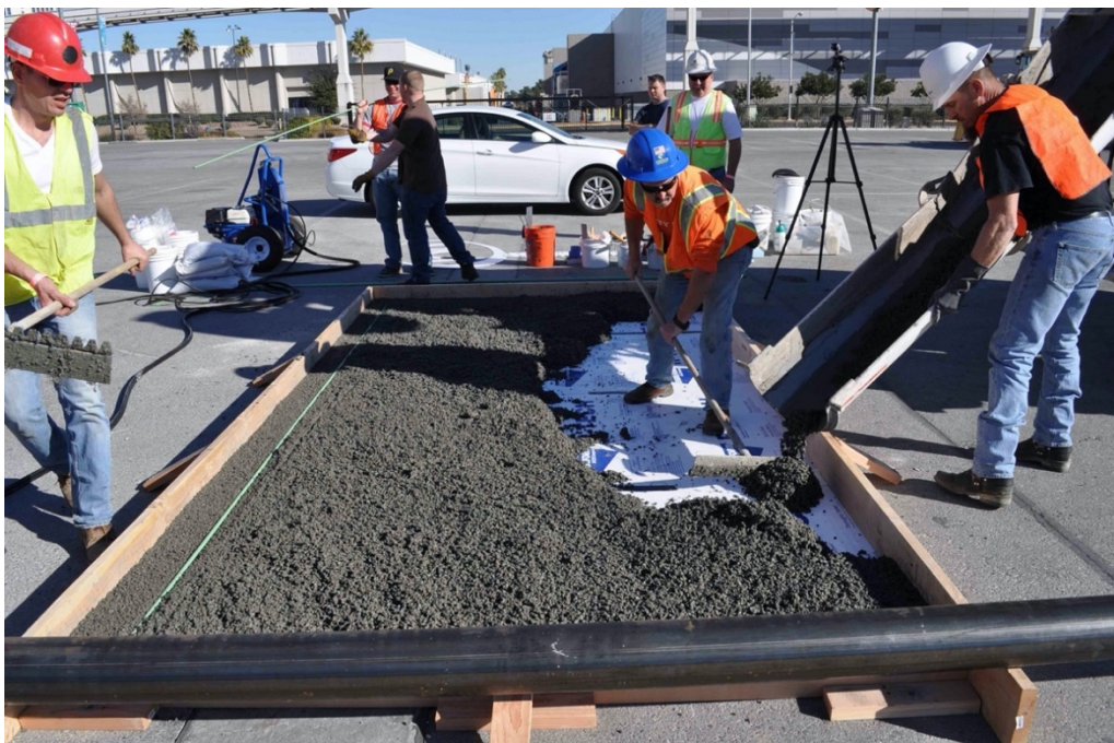
Slika 14: Ugradnja procjdnog betona [9]
