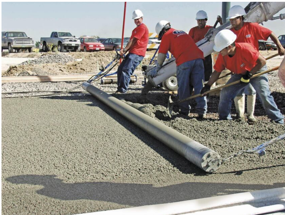
Slika 15: Zbijanje betona čeličnim valjkom [9]
