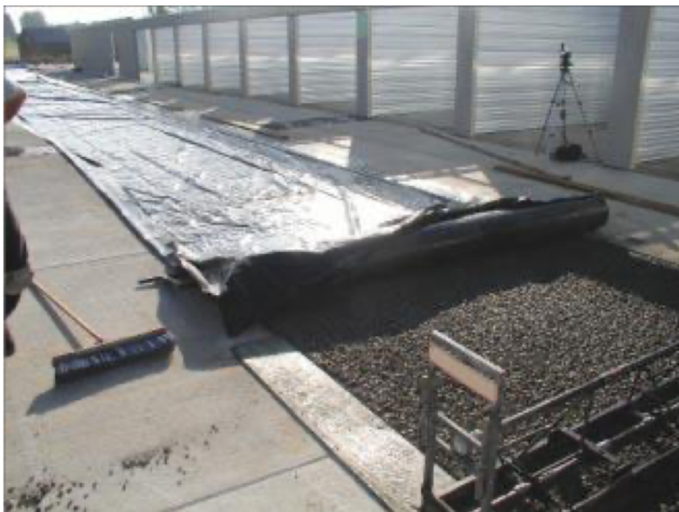
Slika 16: Njega betona nakon ugradnje [2]
